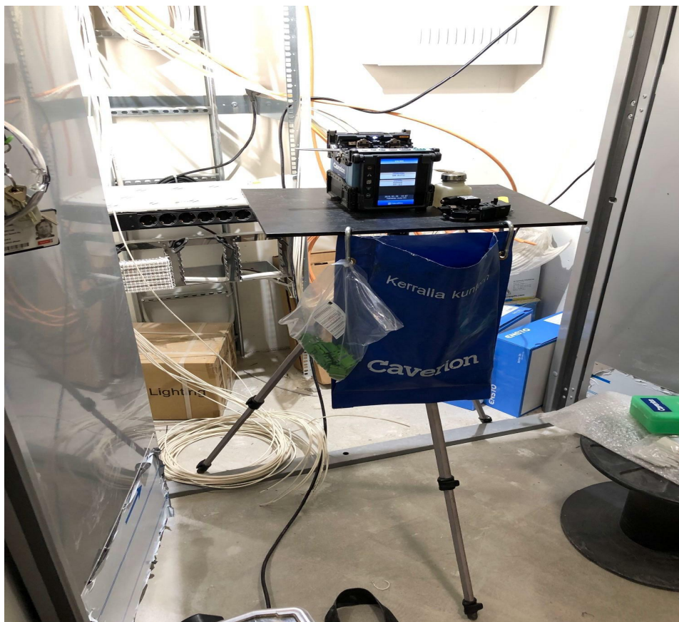
Kuva 14. Valokuituasennuksia varten rakennettu säädettävä työtaso kameran kolmijalasta ja muovilevystä.
