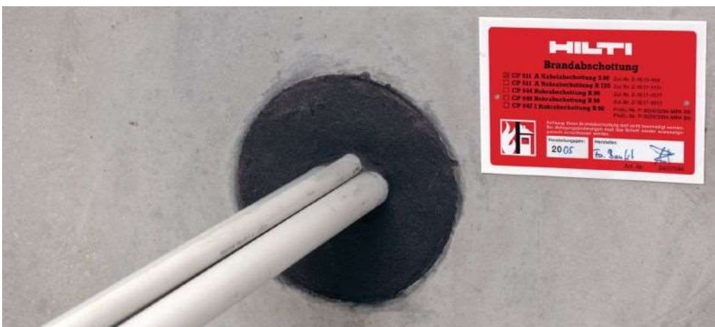
KUVA 4. Laajeneva palokatkomassa (CFS-IS Laajeneva palokatkomassa. 2019.)
