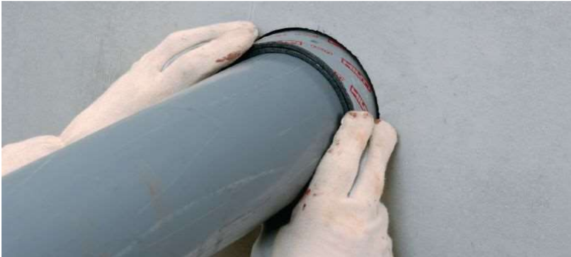
KUVA 7. Palokatkonauha (CFS-W SG Palokatkonauha. 2019.)
