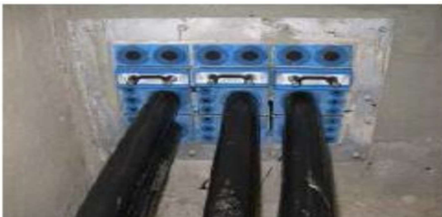
KUVA 9. Modulaarinen palokatko (Osastoivat läpiviennit ja -saumaukset. 2013, 11.)
