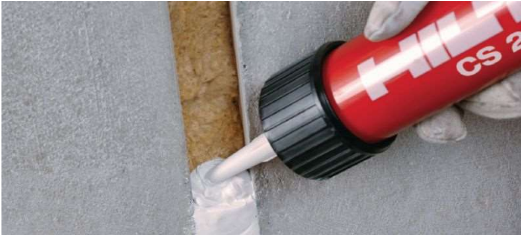
KUVA 3. Elastinen palokatkomassa (CFS-S SIL Silikonipohjainen palokatkomassa. 2019.)
