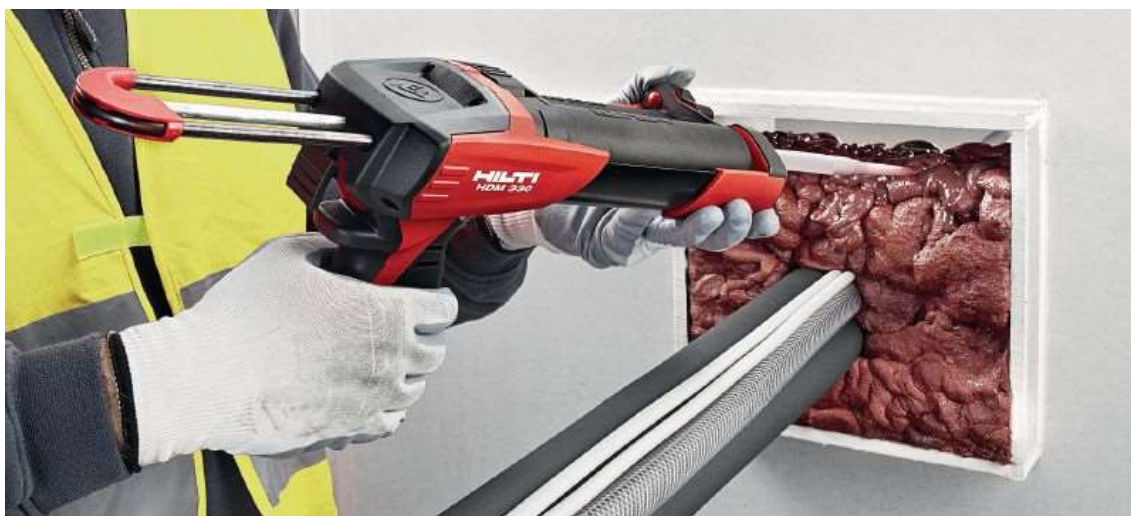
KUVA 5. Joustava palokatkovaahto (CFS-F FX Joustava palokatkovaahto. 2019.)
