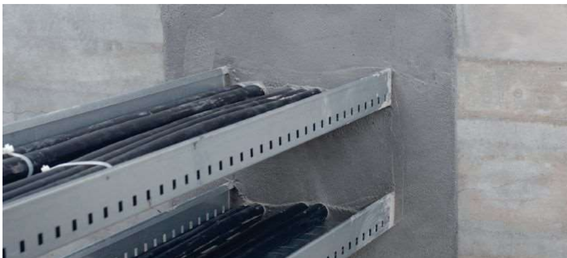
KUVA 1. Sementtipohjainen palokatkomassa (CFS-M RG Sementtipohjainen palokatkomassa. 2019.)
