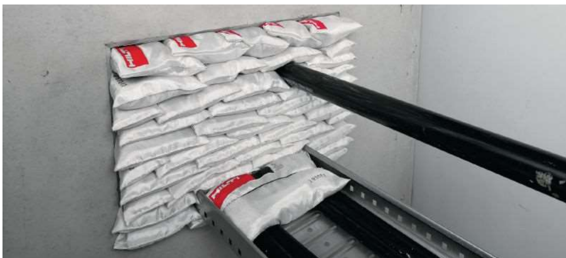
KUVA 10. Palokatkotyyny (CFS-CU Palokatkotyyny. 2019.)
