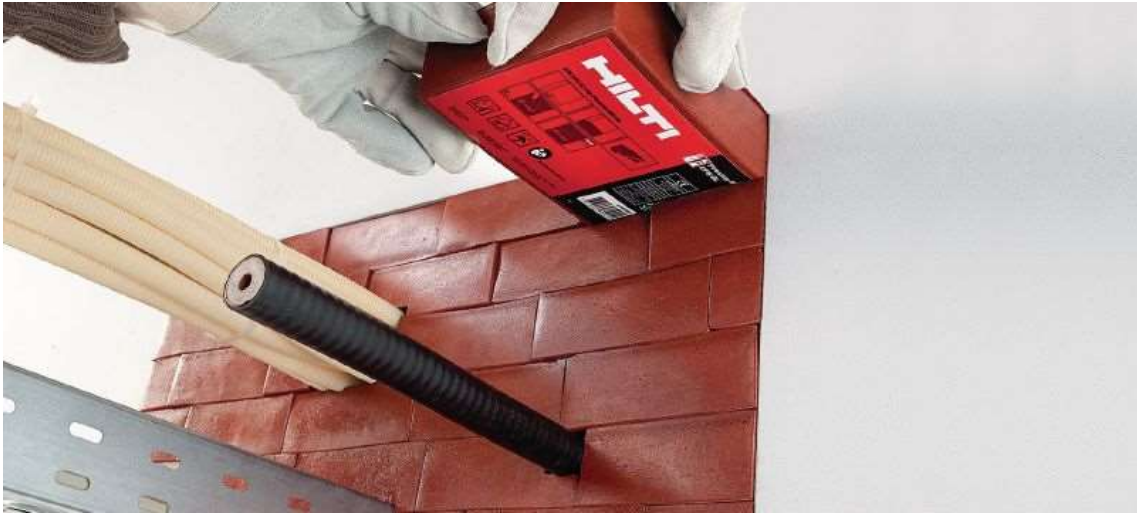
KUVA 12. Palokatkoitiili (CFS-BL Palokatkoitiili. 2019.)
