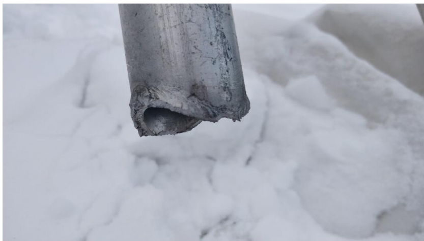
Bild 1: Haveri av aluminiumkonstruktion
