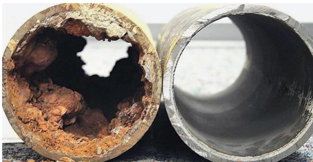
Kuva 6 Vasen putki on avattu poraamalla ja oikea on puhdistettu erään- laisella painepesurilla (Plumbing-draincleaning.com)
