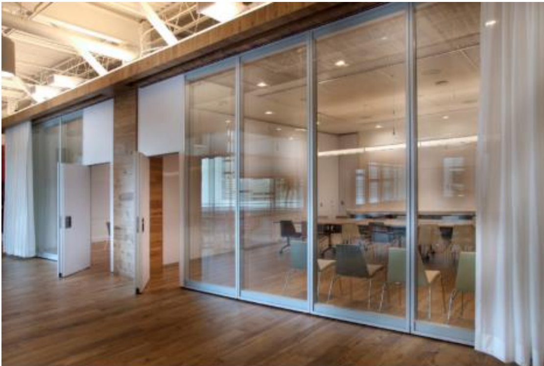
KUVA 8. Lasinen siirtoseinä toimistotilassa (16)
