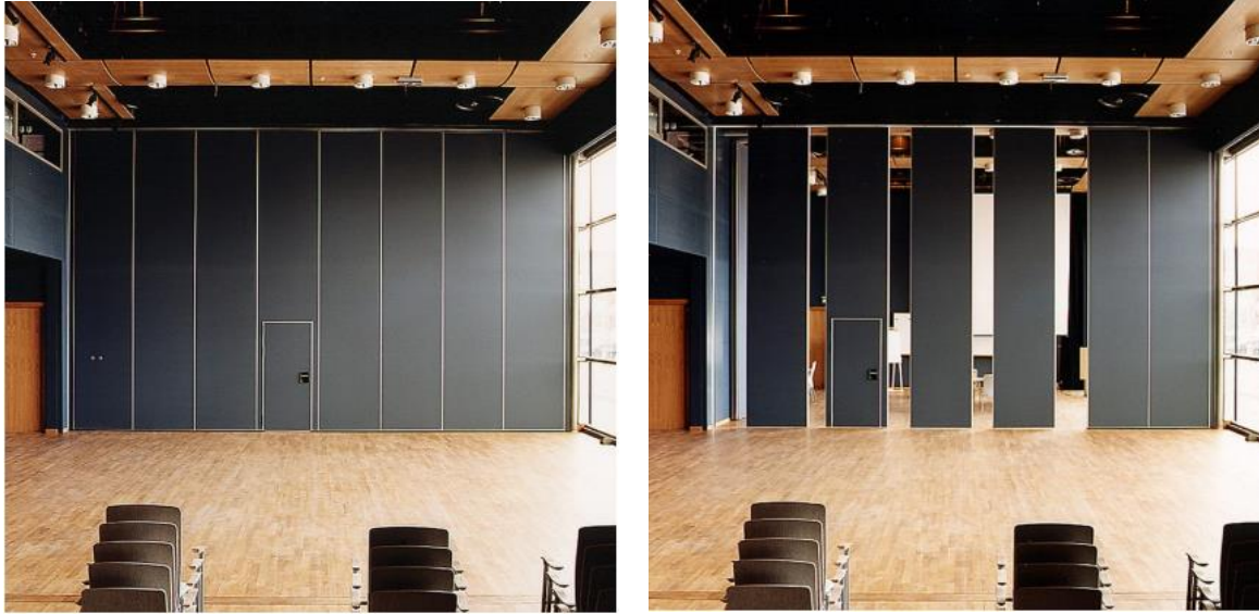
KUVA 7. Siirtoseinät koostuvat toisistaan irrallisista elementeistä (15)
