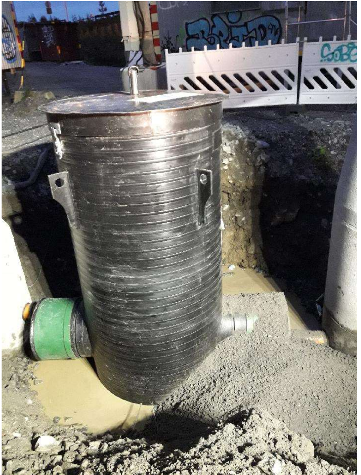
Kuva 10. Supistusyhteet poistokaivossa.
