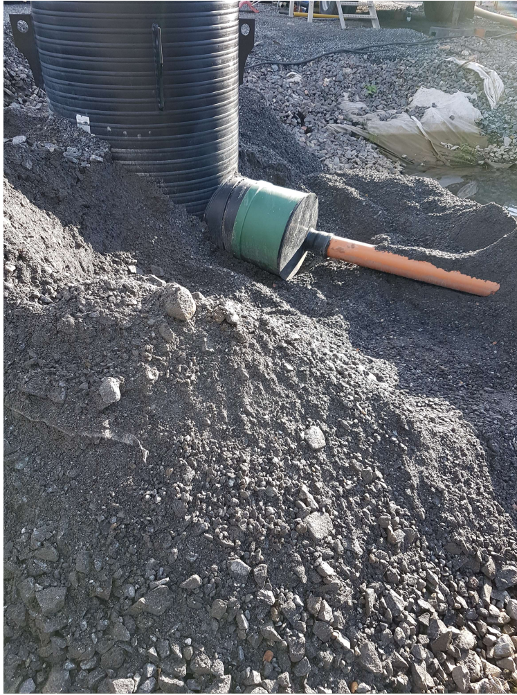
Kuva 11. Supistusyhte tulokaivon poistopäässä.
