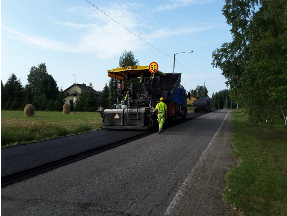
Kuvio 2. Asfalttibetonin levitystä koneellisesti (Salmijärvi 2019)
