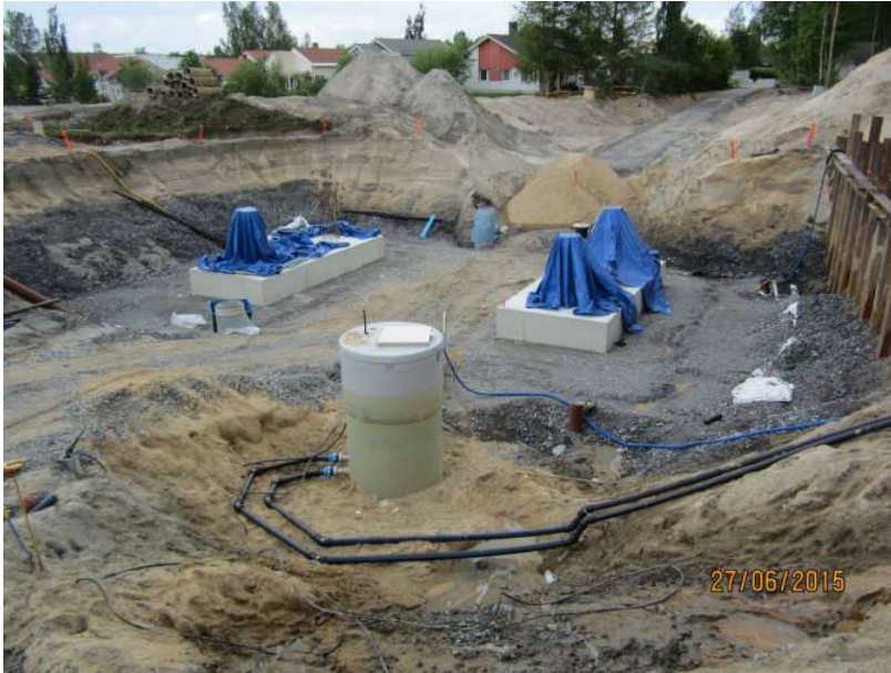
KUVA 17. Massanvaihto tehty, kuivatukset ja pumppaamo asennettu ja peruslaatat valettu (13)
