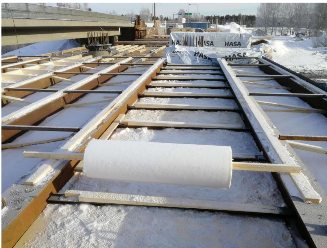
KUVA 38. 22.2.2019 Aukon1 palkit paikoillaan, muotopuut palkkien välissä
