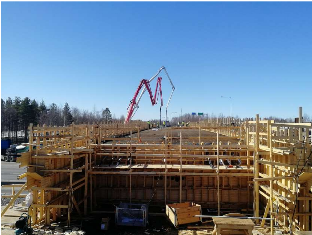
KUVA 50. 16.4.2019 Kiviniemen risteyssillan päällysrakenteen betonointi
