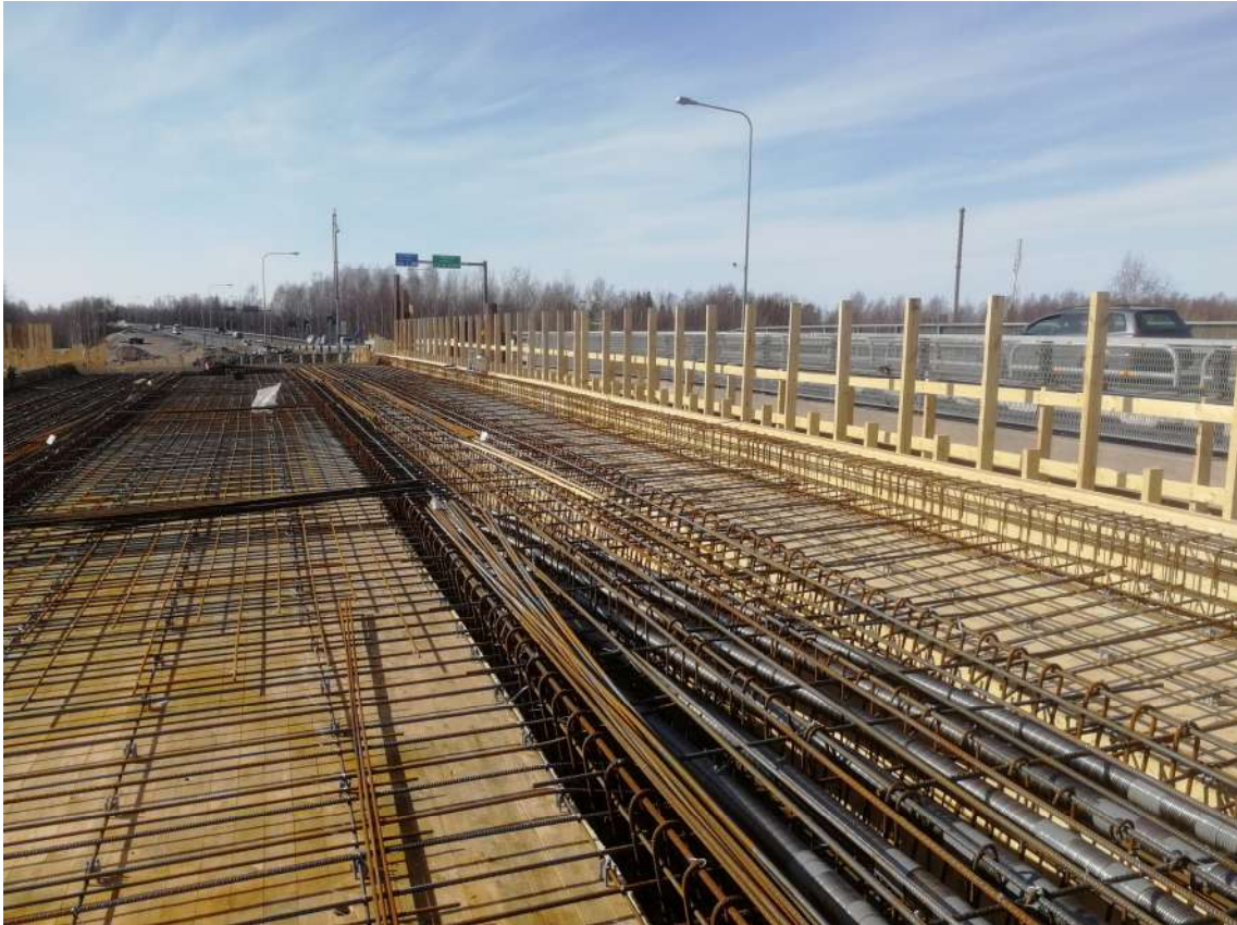
KUVA 45. 3.4.2019 Risteyssillan raudoitus etenee
