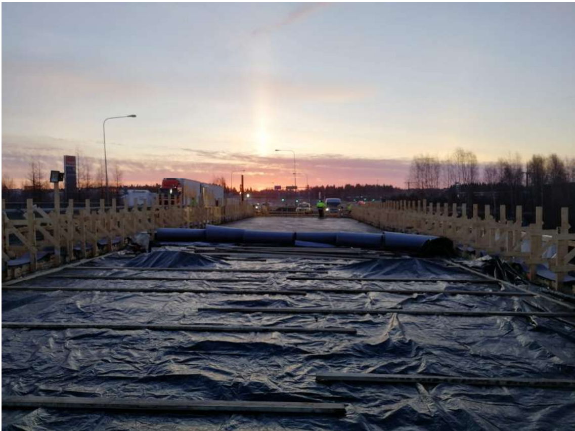
KUVA 51. Sillan kannen hierto ja betonoinnin jälkityöt käynnissä
