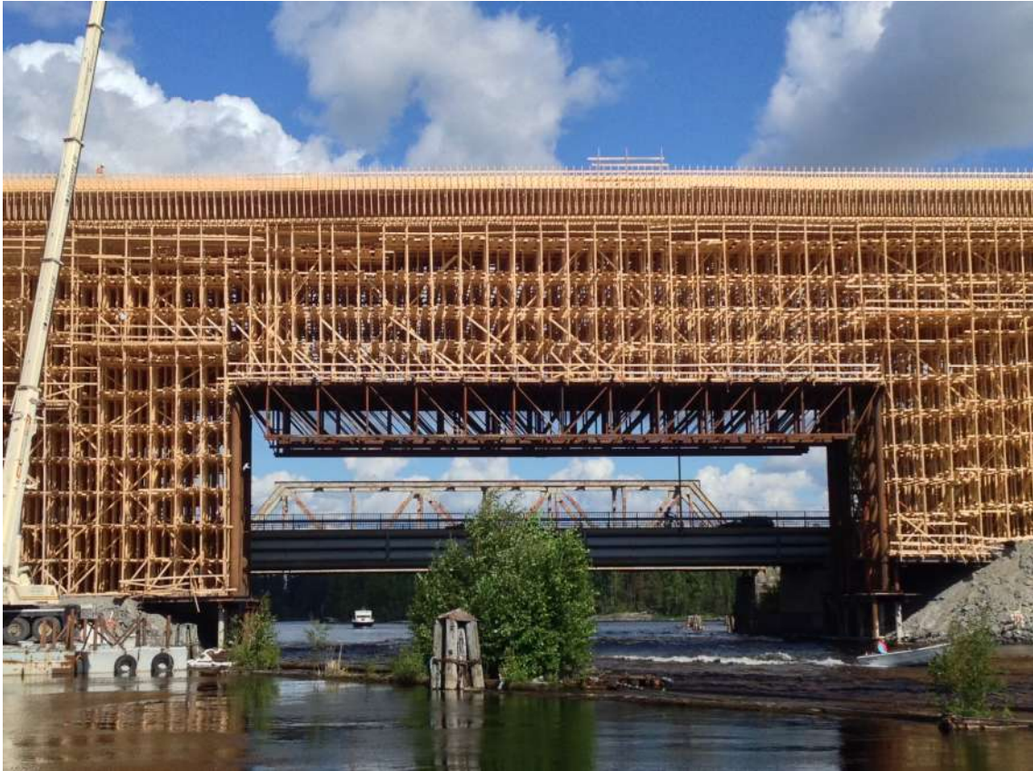
KUVA 13. Laitaatsalmen jännitetyn betonisen palkkisillan teline ja veneilyaukko (14)
