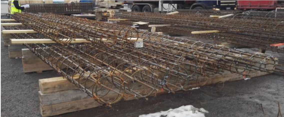
KUVA 30. Paaluraudoitteiden raudoitustarkastus käynnissä 28.4.2017
