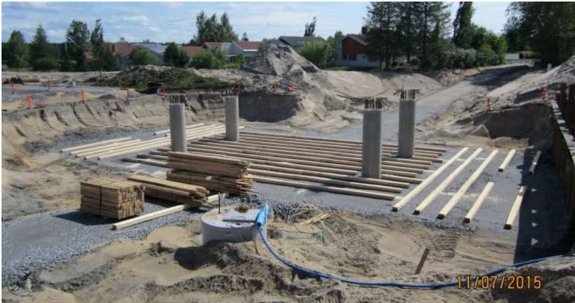
KUVA 21. Ulokelaattasillan telineen pohjat ja pelkotus (13)
