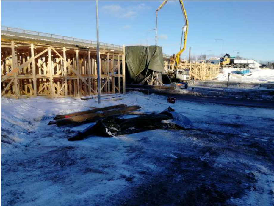
KUVA 33. Tuen T2 betonointi käynnissä 11.2.2019
