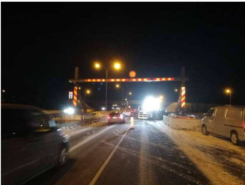
KUVA 35. Raskaan suoja-portin asennus tehtiin yötyönä 20.2.2019
