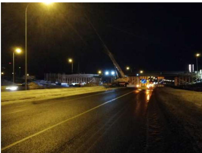
KUVA 37. Liikenneaukkojen teräspalkit asennettiin yötyönä
