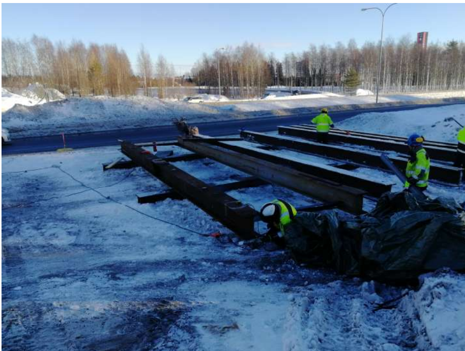
KUVA 34. Aukon 1 telipalkkien hitsaus käynnissä 11.2.2019
