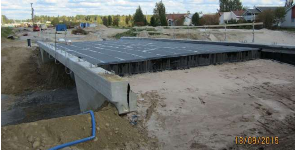
KUVA 25. Vesieristetty sillan pääty ja sillan kansi (13)
