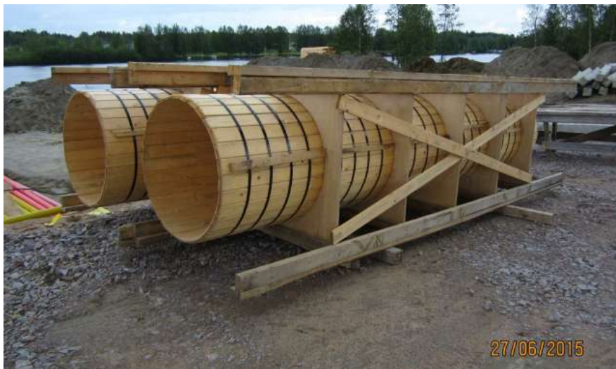
KUVA 19. Pilarien esivalmistetut muotit ennen asennusta (13)
