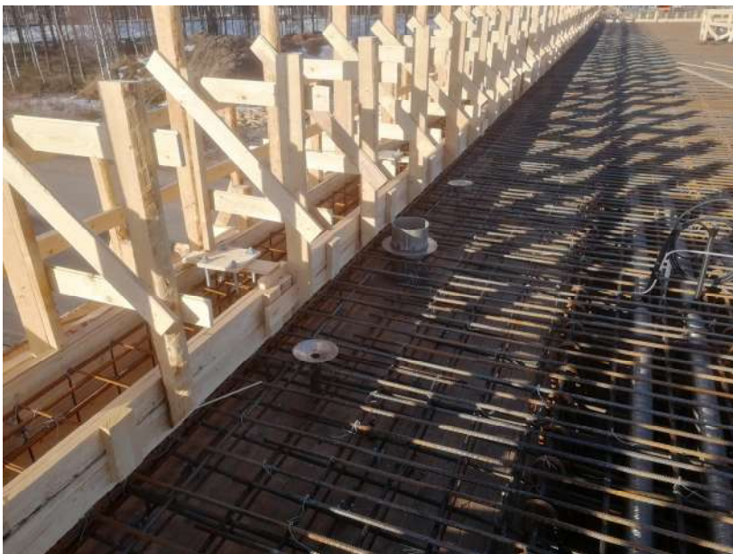
KUVA 49. Pulttiryhmä, sadevesikaivo ja pintavesiputkia
