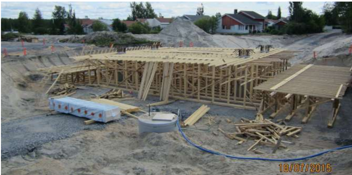
KUVA 10. Ulokelaattasilan päällysrakenteen telinerakennus käynnissä (13)
