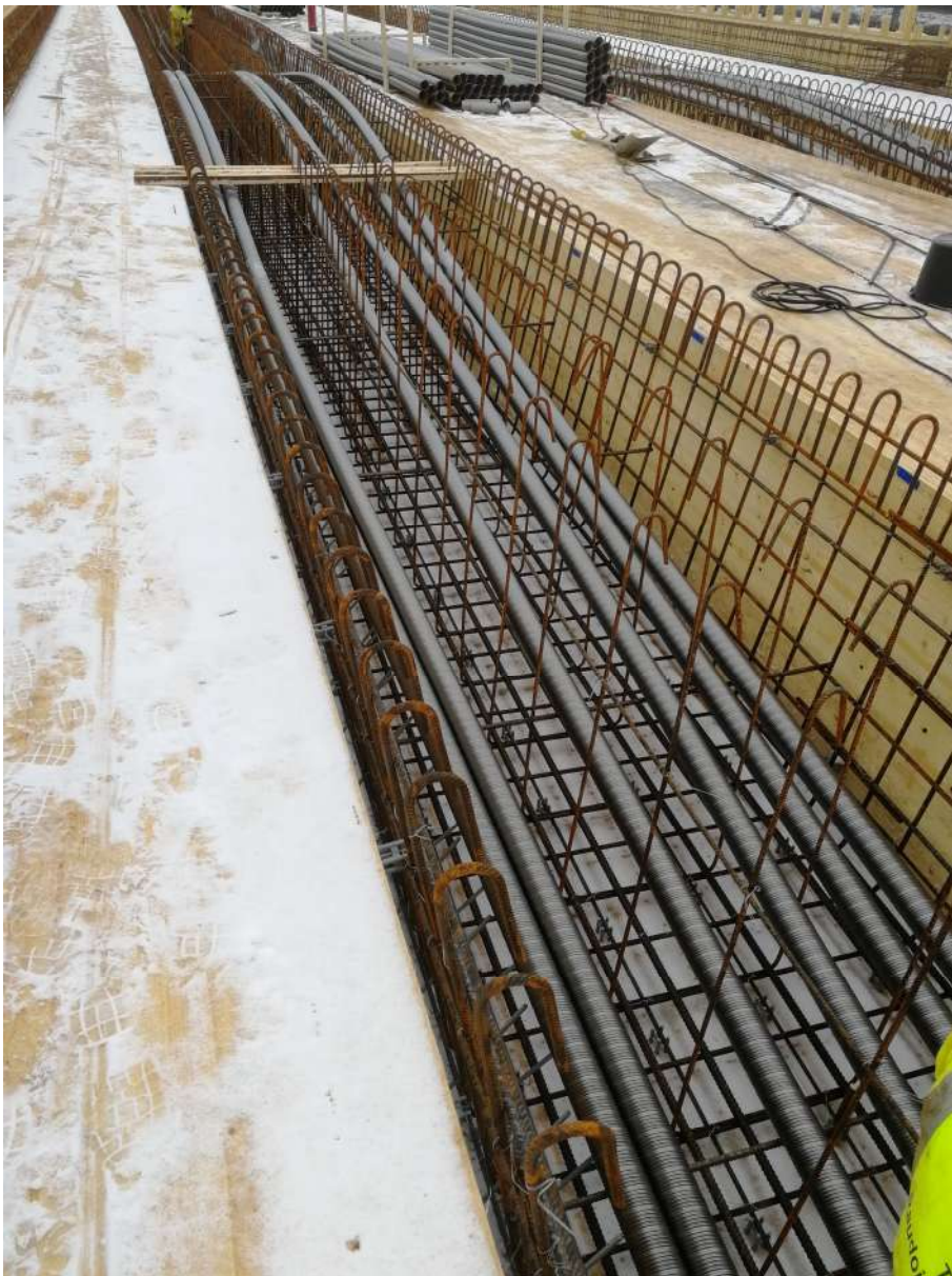
KUVA 42. Pääpalkin pääteräkset ja jänneputken orret sekä jänneputket
