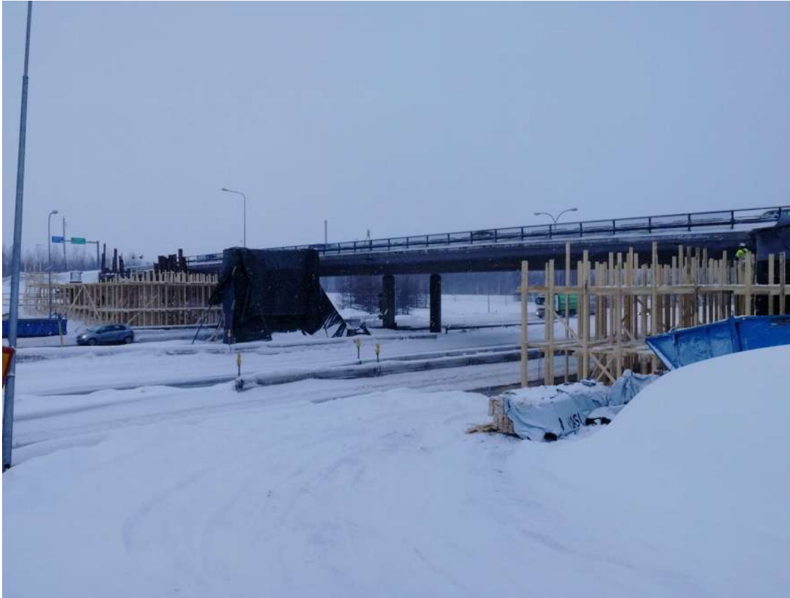
KUVA 31. Kuvan keskiosan pilarit huputettuna odottamassa valukeliä 4.2.2019
