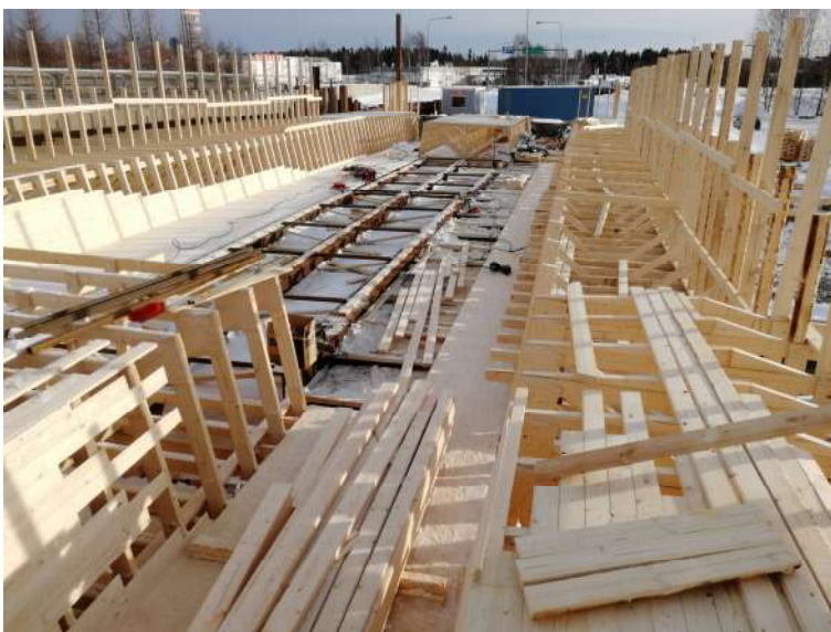
KUVA 40. Muottityöt käynnissä aukkojen 2 ja 3 päällä 5.3.2019
