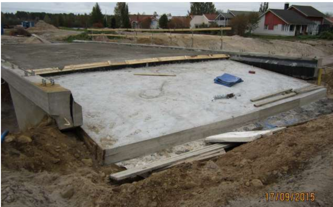
KUVA 26. Siirtymälaatat valettu ja vesieristys suojattu suojabetonilla (13)
