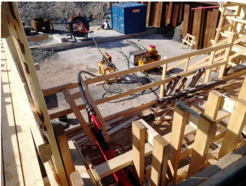
KUVA 47. Jännepunosten työntölaitteisto ja jännepunos syöttölaitteessa
