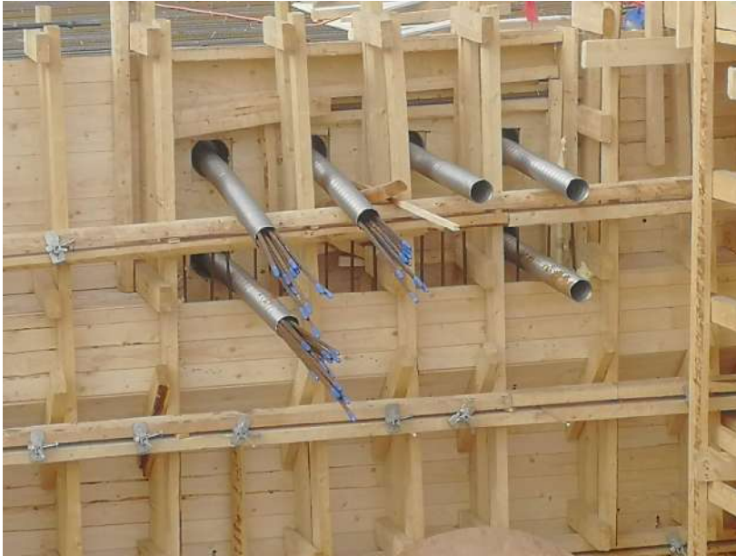
KUVA 46. Ammutut jännepunoksen päät riippuvat kuvassa vapaana
