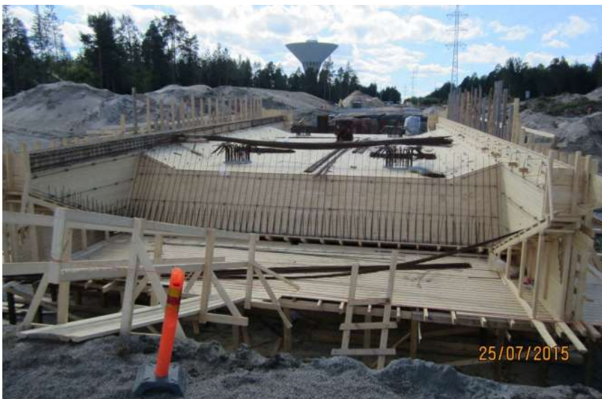
KUVA 11. Ulokelaattasillan muotti, raudoitus aloitettu (13)
