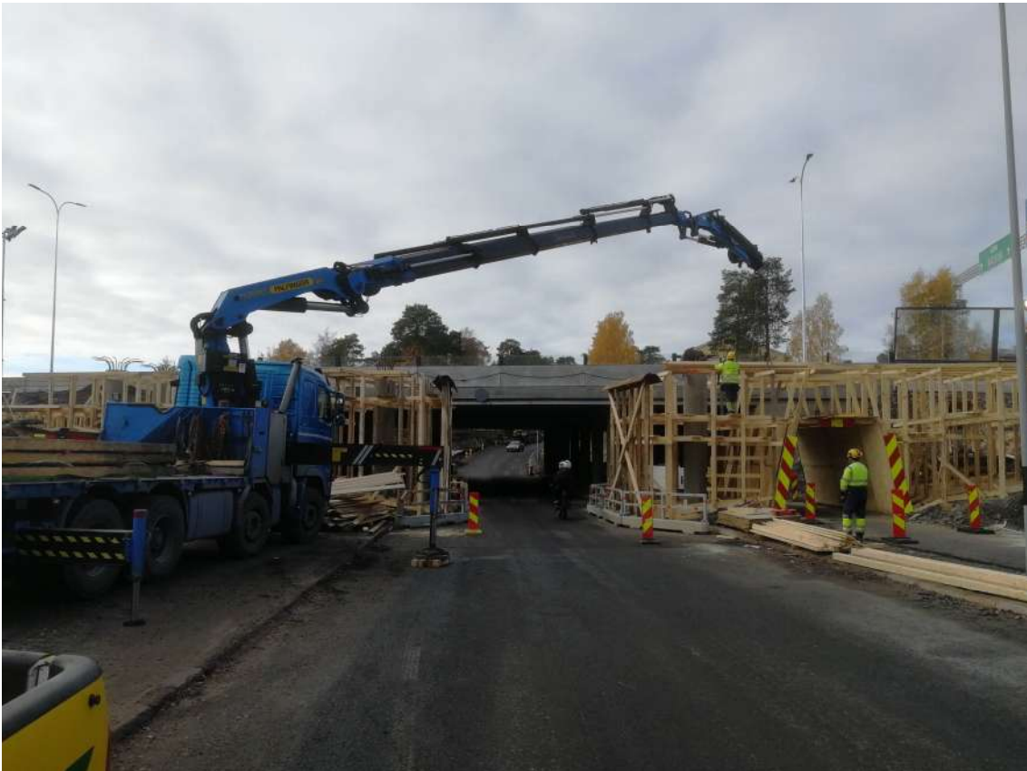
KUVA 12. Hintantien YKK:n – Ulokelaattasillan telinetyöt käynnissä 11.10.2018
