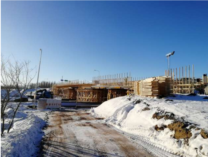
KUVA 39. 4.3.2019 Muottityöt käynnissä sillan telineellä
