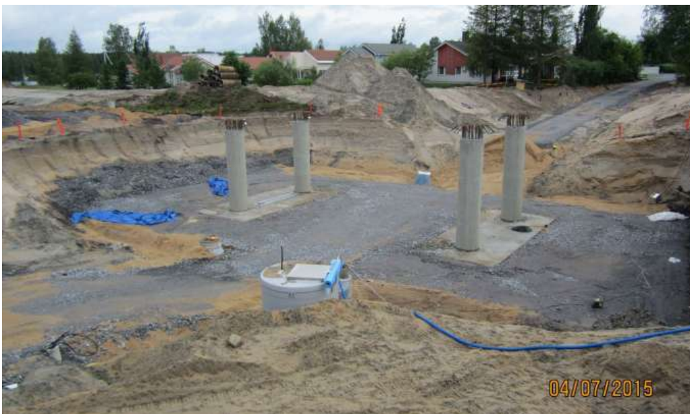
KUVA 18. Sillan alusrakenteet betonoitu ja ympärystäytöt tehty (13)
