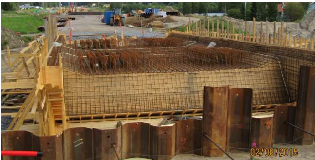
KUVA 23. Raudoituksen alapinta ja leikkausraudoitus pilarien kohdalla (13)
