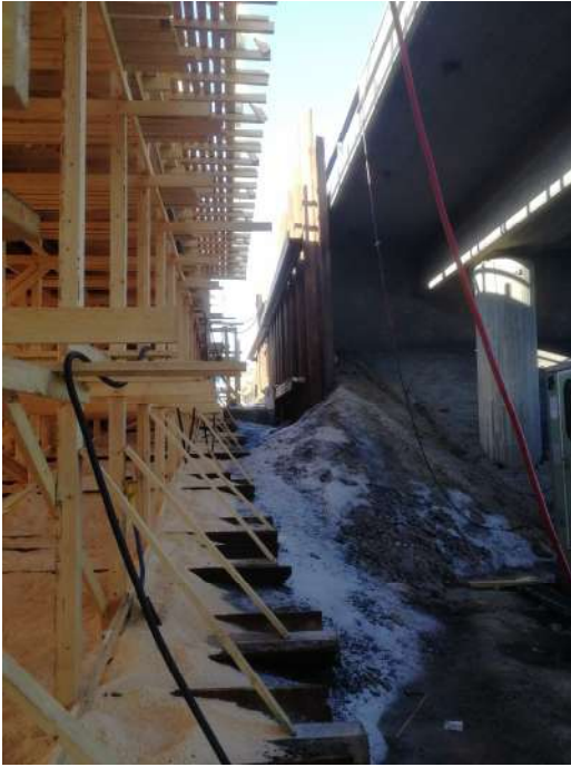
KUVA 28. Ponttiseinä tukemassa olemassa olevia rakenteita 5.4.2019
