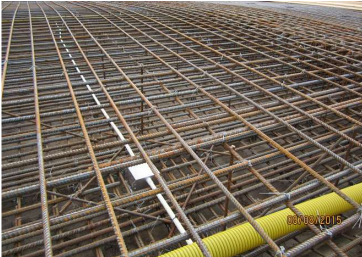
KUVA 24. Yläpinnan raudoitusta ja varusteita (13)
