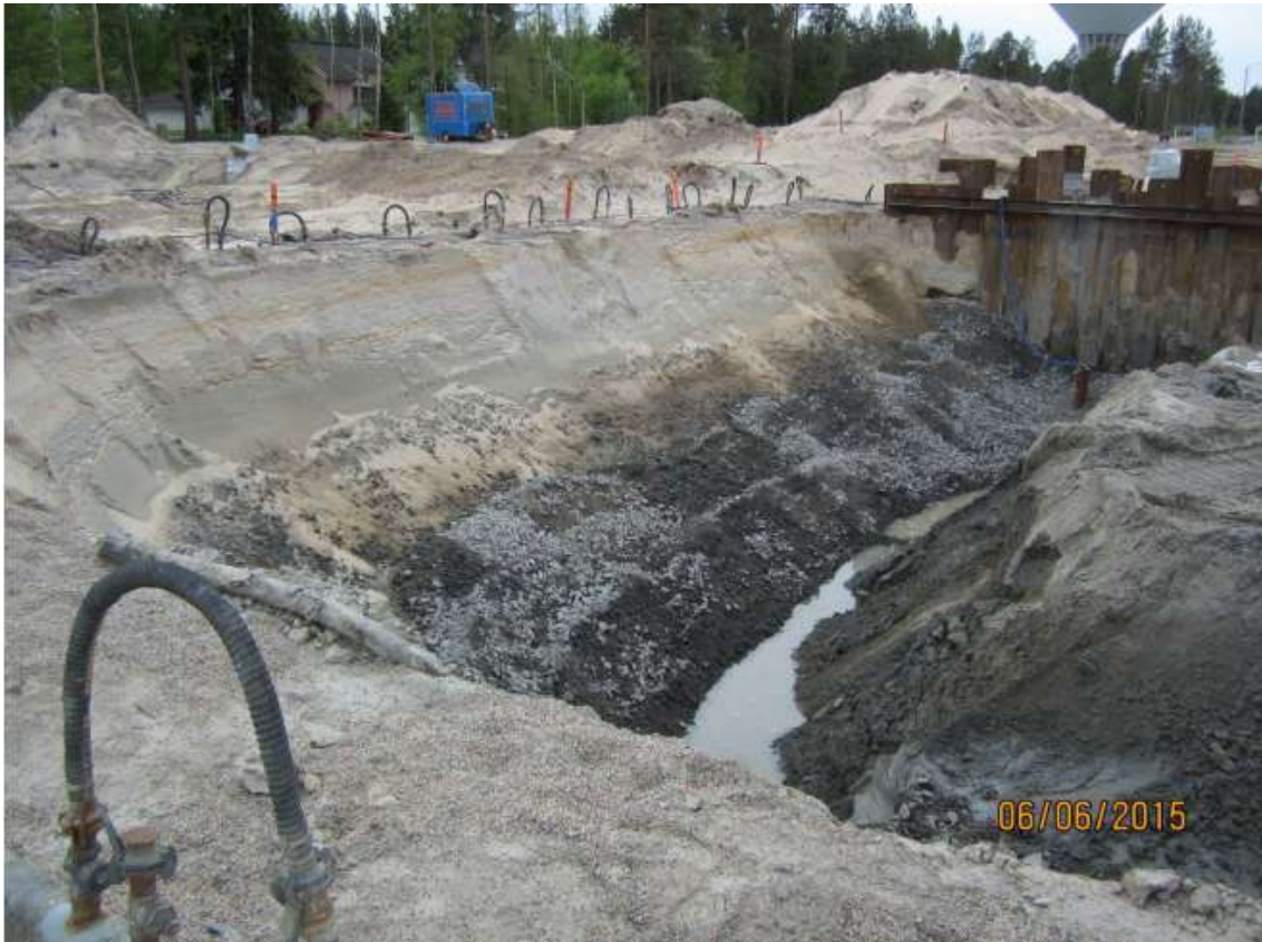
KUVA 16. Viettoviemäri ja pohjavesi aiheutti haasteita massanvaihdon suorittamiselle (13)
