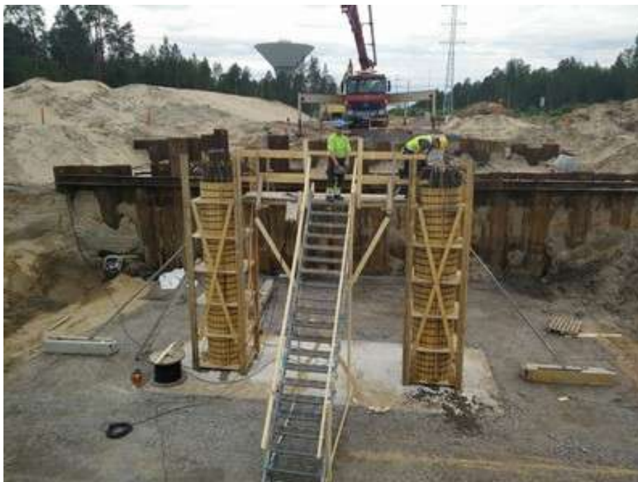
KUVA 20. Pilarien betonointi valmiina alkamaan 2.6.2015
