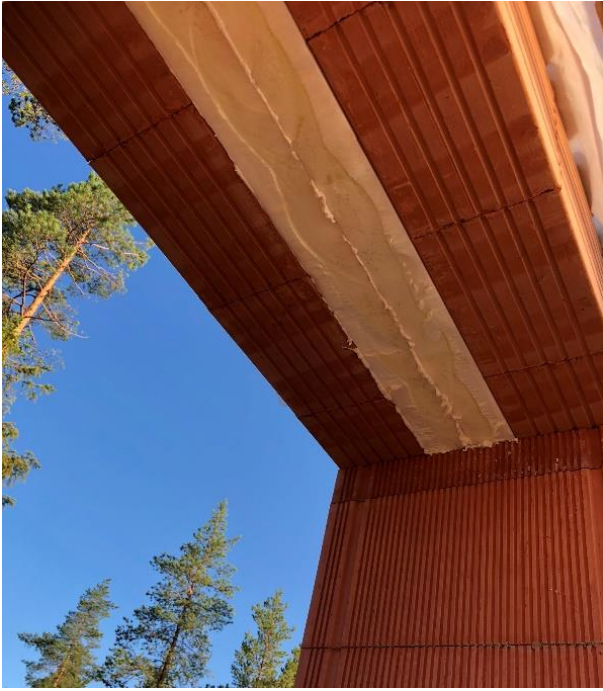
KUVA 5. Polyuretaanieristettä aukonylityspalkkien välissä
