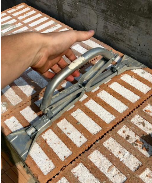
KUVA 6. Poroton-harkon asennussakset
