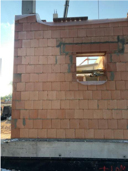
KUVA 2. Harkkomuurauksen nurkan limitys
