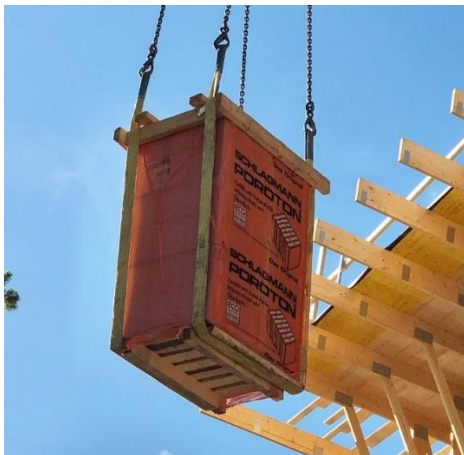
KUVA 8. Poroton-harkkoletkan nostaminen
