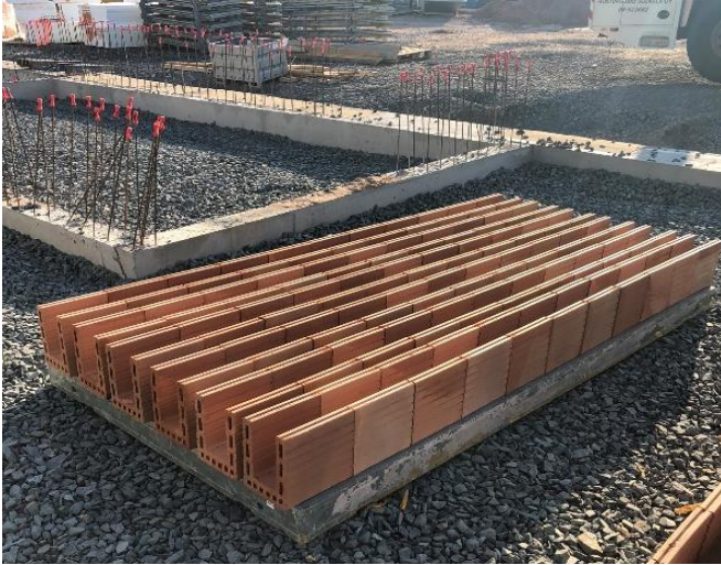
KUVA 4. Aukonylityspalkkien valmistaminen maassa
