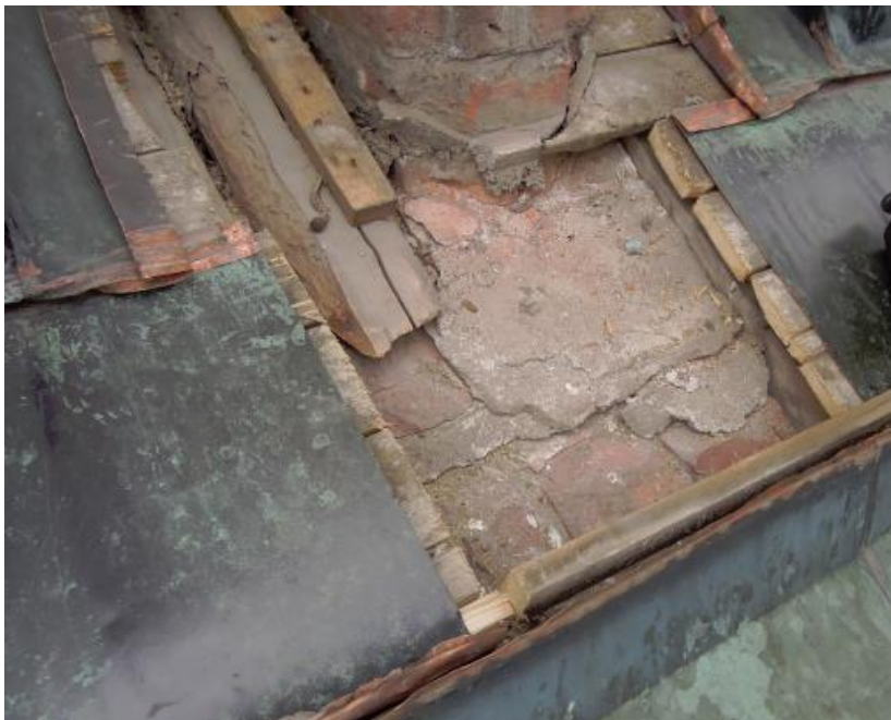
Kuva. Pilasterin ja räystäään kohdalta.
