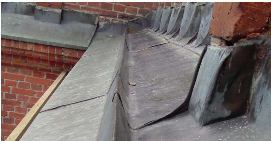
Kuva. Kattosaumat.
