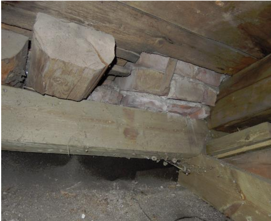
Kuva. Pilasterin tausta näkyy ullakon puolelta.
