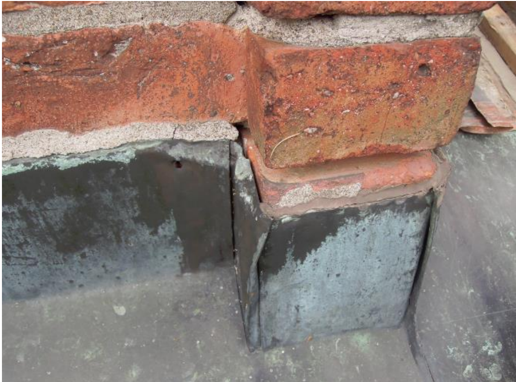
Kuva. Katon ja pilasterin liitoskohta.
