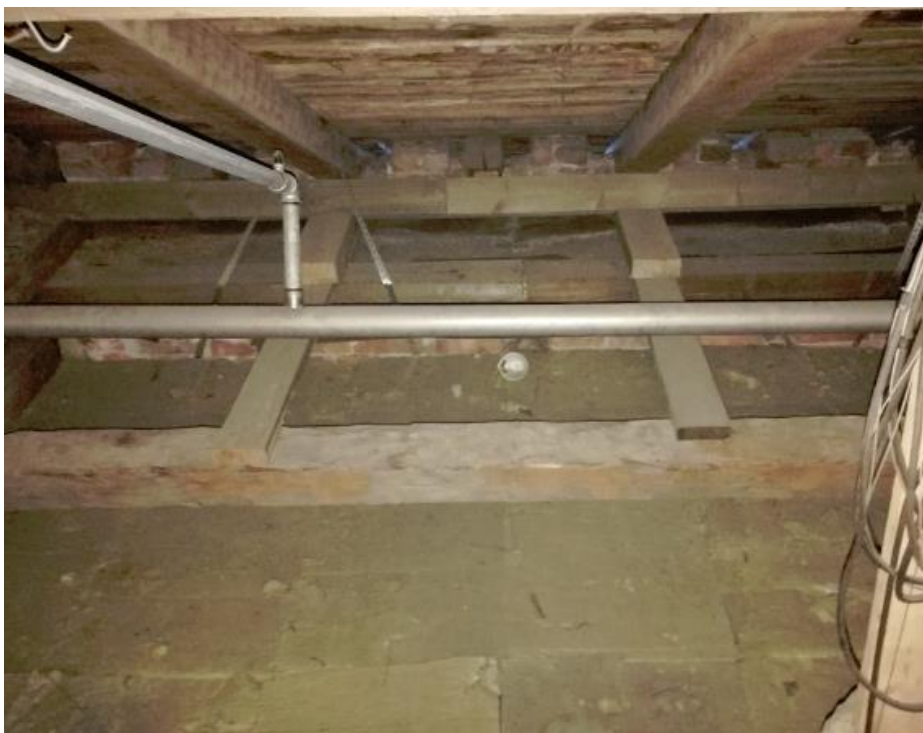
Kuva. Yläpohjan lasivillaa, sammutusjärjestelmä ja kattovasa.
