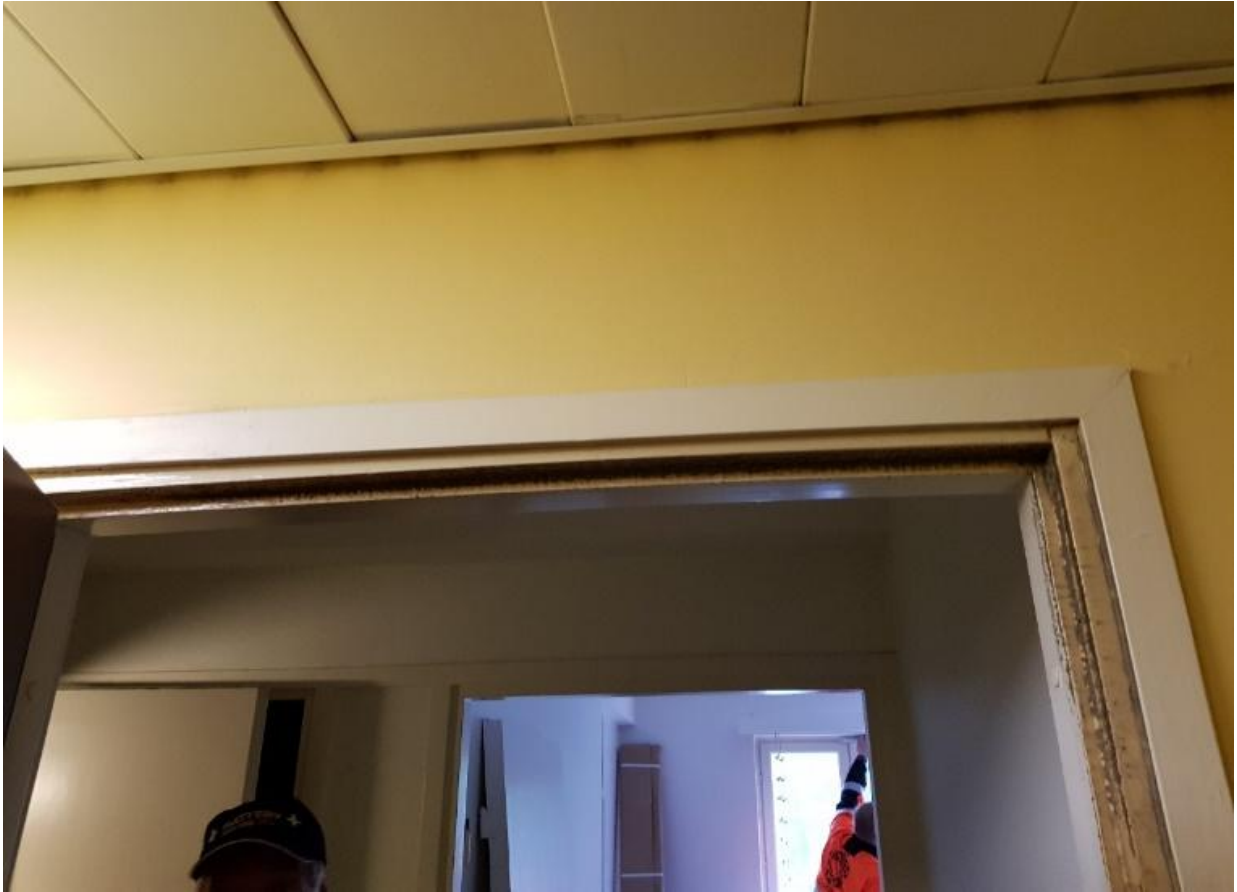
Kuva 5. Ulko-oven karmiin on kertynyt rasvaa ja pölyä. Kuvaaja Jaakko Raikaa 2019
