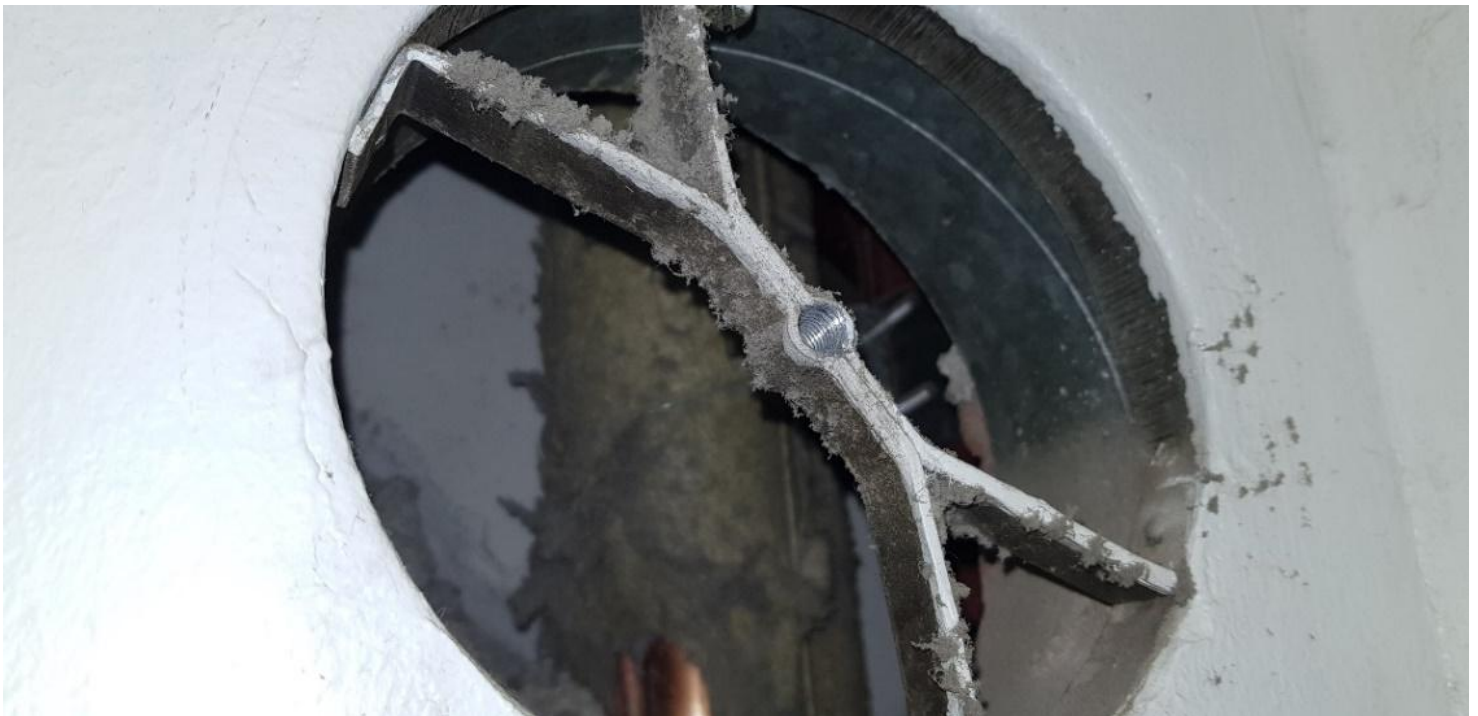
Kuva 4. WC-tilan poistoilmaventiili liitetty putkinousu koteloon. Kuvaaja Jaakko Raikaa 2019
