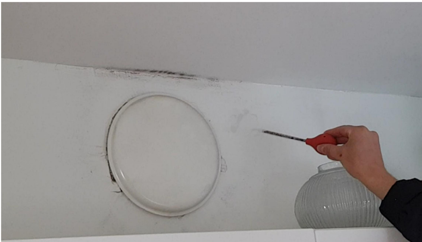
Kuva 3. Savukokeella todettiin keittiön poistoilmaventtiilin toimivan korvausilmaventtiilinä. Kuvaaja Jaakko Raikaa 2019
