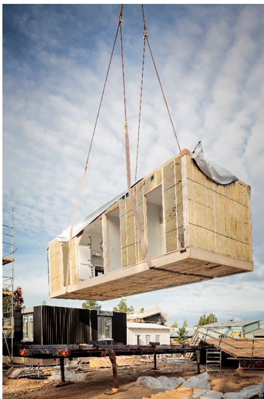
Kuva 6. Tilaelementin nostoa työmaalla (puuinfo.fi)
