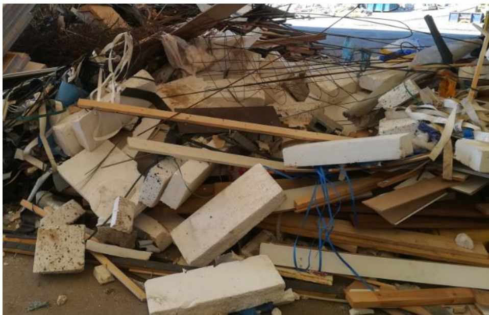
Kuva 4 Lajittelematonta rakennusjätettä (Lindberg 2018)
