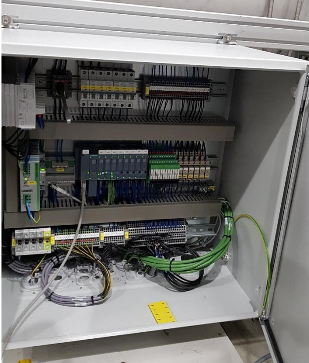
KUVA 21. Kenttäkotelo +A4 asennusvaiheessa
