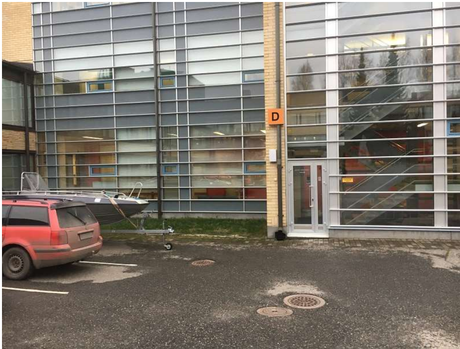
Kuva 12. D-siivekkeen käytävä ulkopuolelta.
