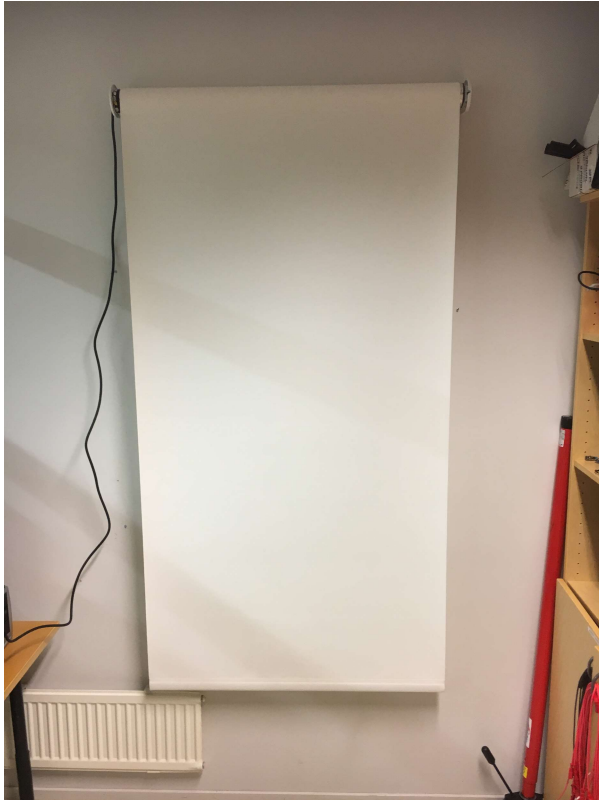
Kuva 30. Moottoroitu screenkaihdin ala-asennossa talotekniikanlabrassa.
