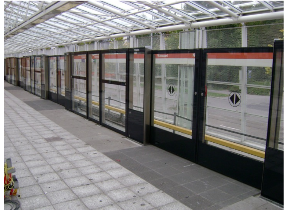
Kuva 11. Laituriovet Vuosaaren asemalla. Kuva: Otto Karikoski
