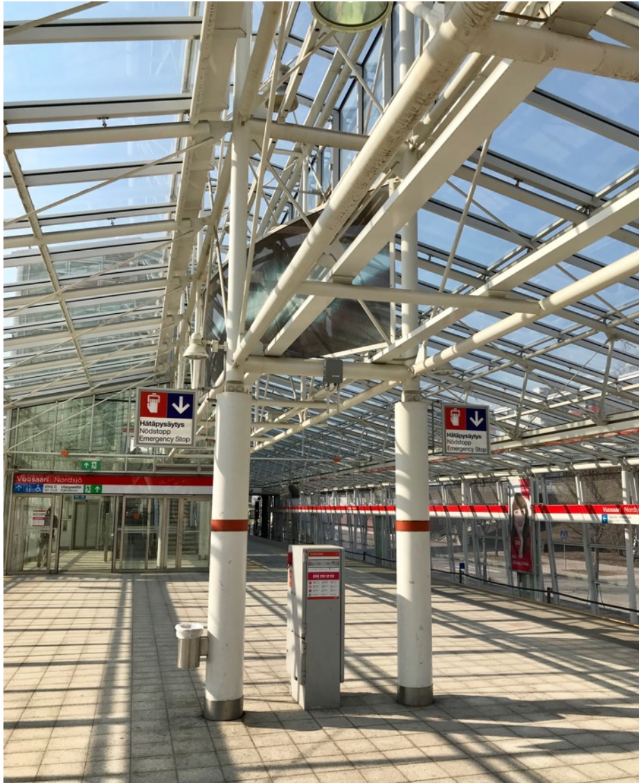
Kuva 165. Vuosaaren aseman teräsrakenteita
