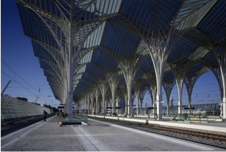
Kuva 152. Lissabonin Oriente-aseman katos, Santiago Calatrava . Kuva: Tafline Laylin.
