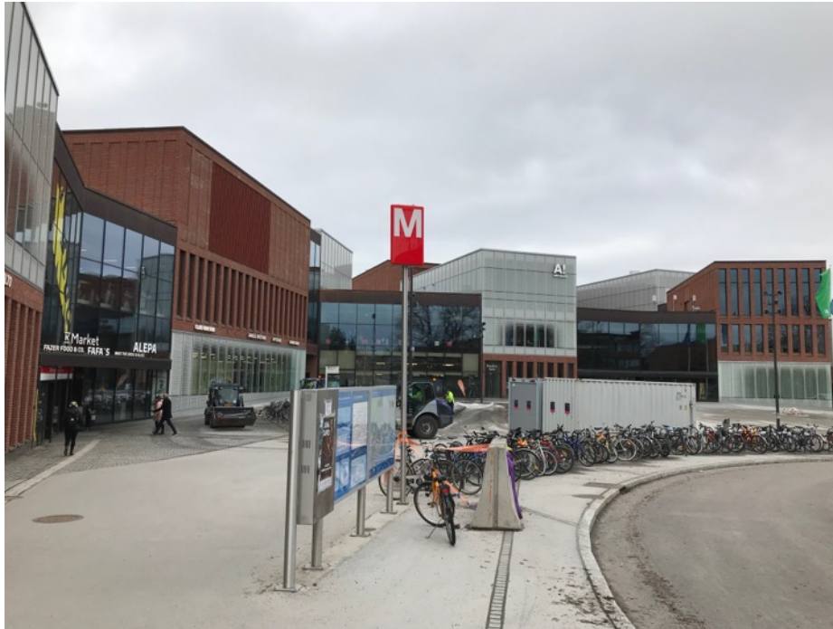
Kuva 158. Sisäänkäyntiaukio, Aalto-yliopiston asema
