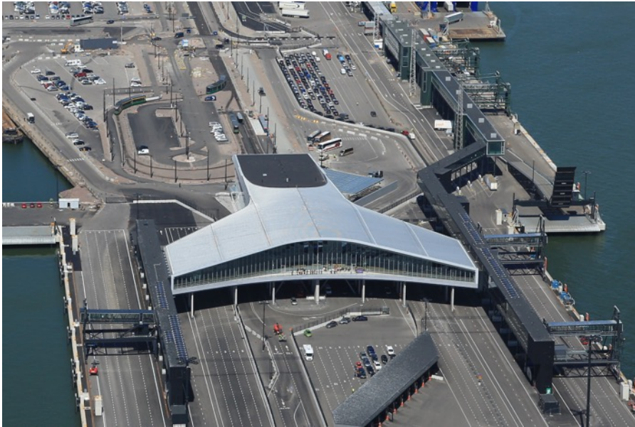
Kuva 187. Terminaalin "rauskumuoto". Kuva: Helsingin Satama / Suomen ilmakuva
