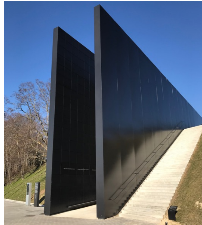
Kuva 184. Muistomerkin levymäiset rakenteet kaivautuvat maastoon
