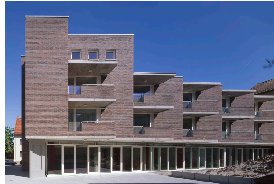
Kuva 33. Kuva pihanpuolelta kohti yhteistiloja ja asuntoparvekkeita (Ledere Ragnarsdottir Oei).
