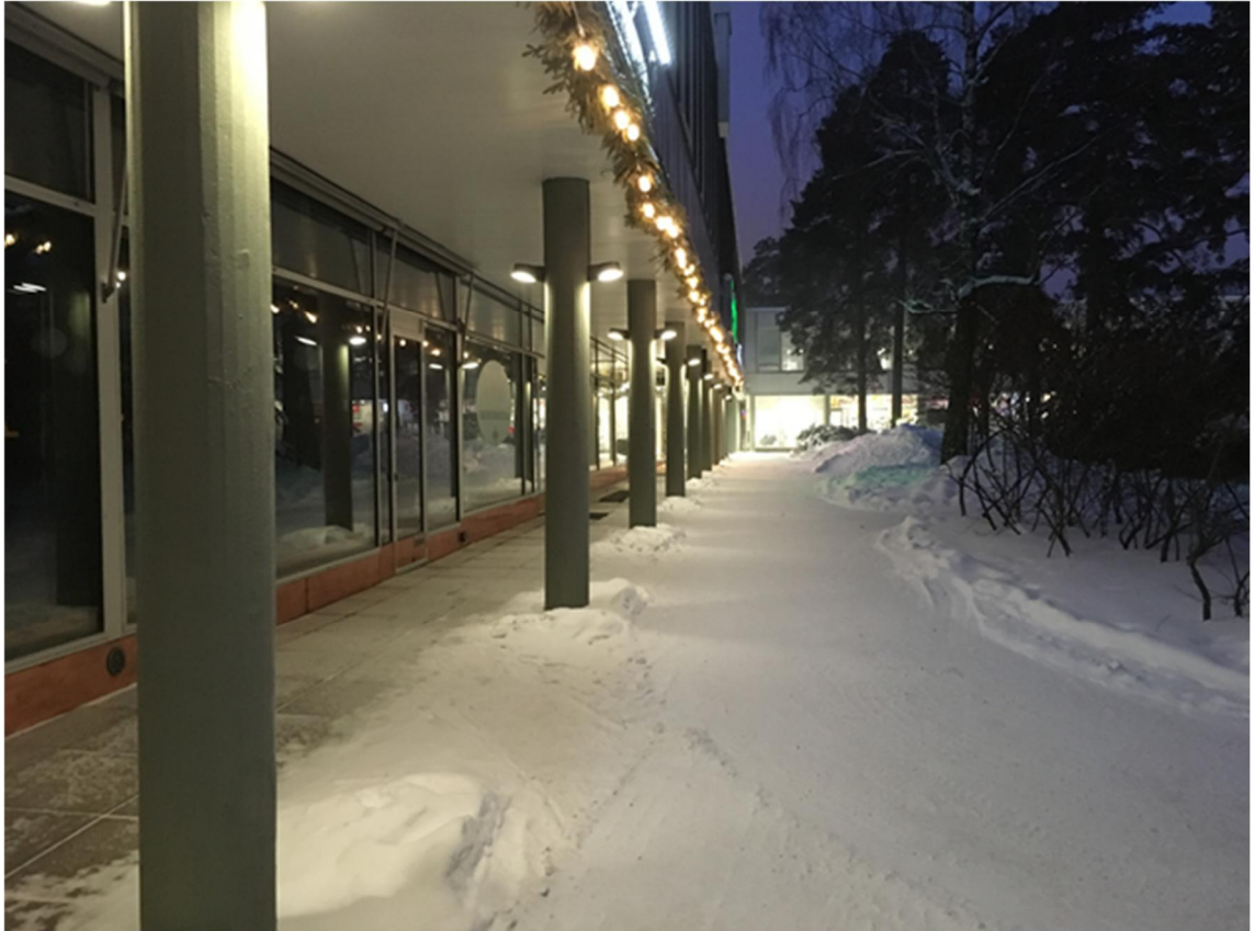
Kuva 2. Arkadikuva Tapiolasta, Espoosta. Bernissä arkadit ovat vielä suojaisempia, koska pili- rien välit kapeampia.
