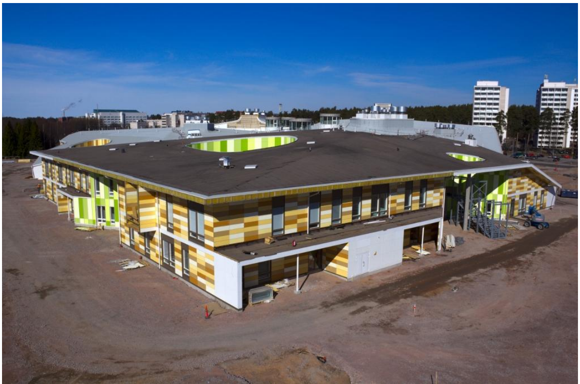
Kuva 9. Kastelli-monitoimitalo, 2010, Lemminkäinen PPP Oy. [17]
