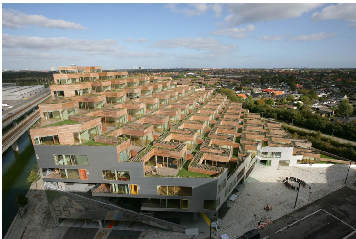
Kuva 13. Mountain Dwellings, 2008, Bjarke Ingels Group. [21]
