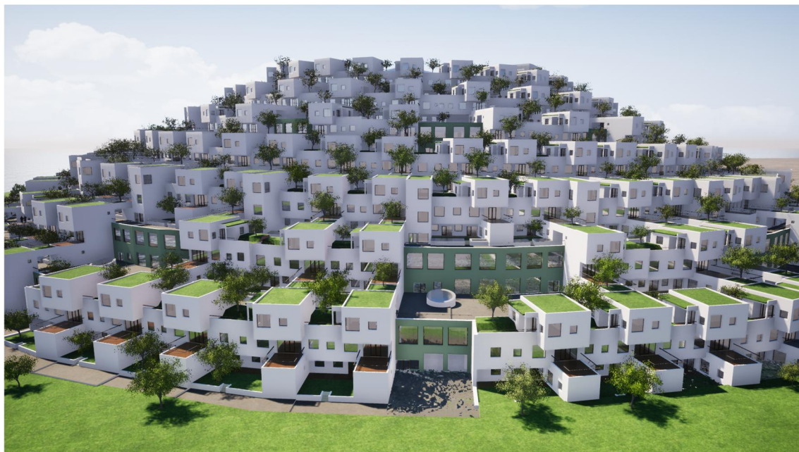
Kuva 20. Rakennuksen kokonaismassa idästä katsottuna.
