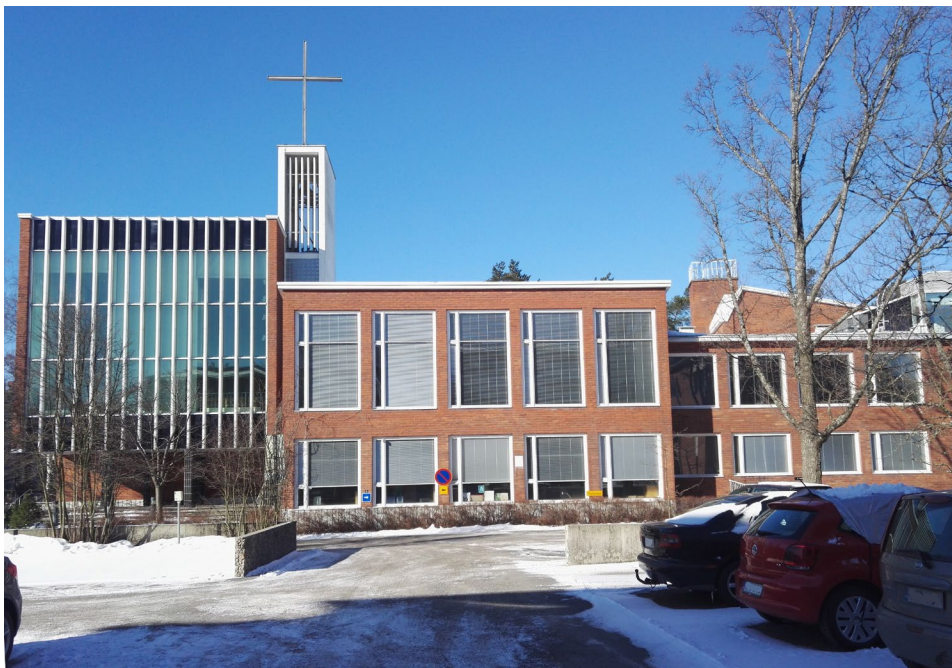
Kuva 10. Kirkkorakennuksen pääjulkisivu suuntaa itään. Kirkkosalin kohta eroaa muusta julkisivusta selkeästi.
