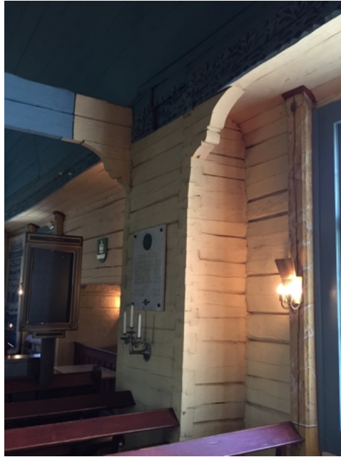
Kuva 7 - Temmeksen kirkon hirsinen tukipilari. (Kuva: kirkkotiella.blogspot.com)
