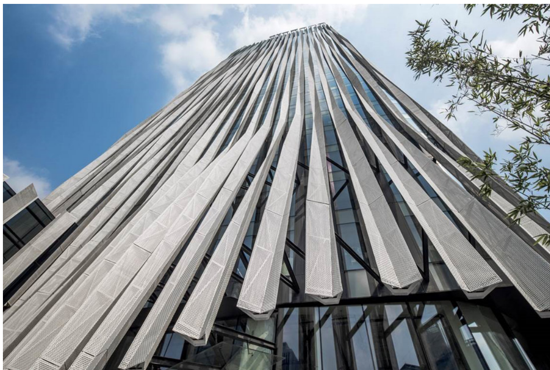
Kuva 103 – Kengo Kuman suunnitteleman Shanghai Tower -pilvenpiirtäjän julkisivussa on perforoitua alumiinilevyä. Se antaa rakennukselle hulmumaisen ja keveän luonteen. (Kuva: Jerry Yin / Dezeen)
