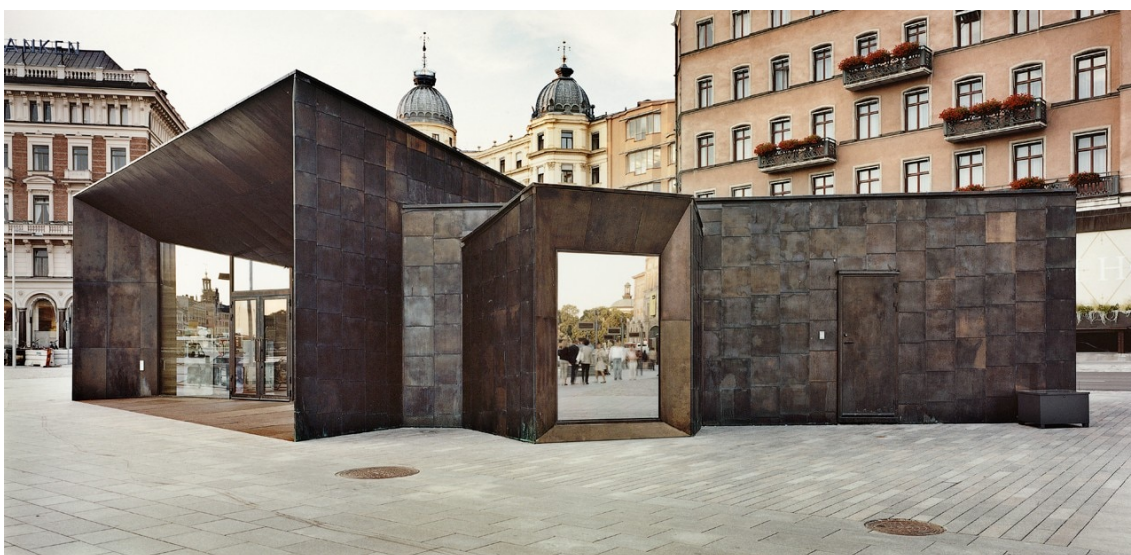
Kuva 104 – Marge Arkitekter -toimiston suunnittelema Strömkajenin terminaalirakennuksessa on hitsattu messinkinen julkisivu (Kuva: Domusweb)
