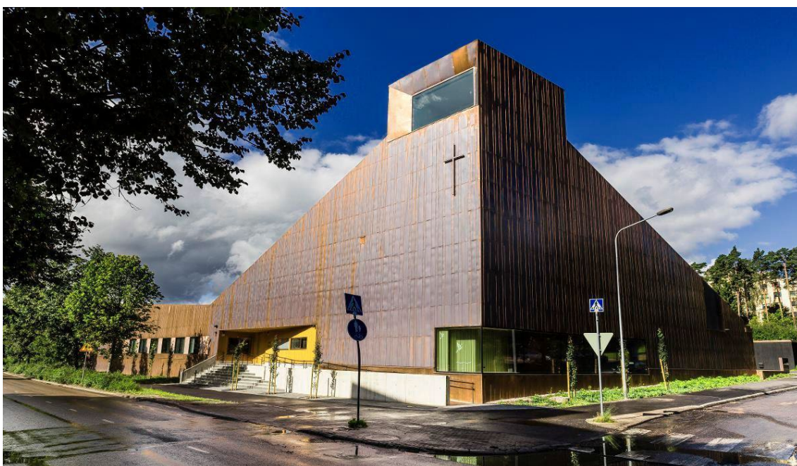
Kuva 39 – OPEEA:n suunnittelema Suvelan kappeli on vuorattu kuparista, joka ajan myötä patinoituu vihertäväksi. Kirkko valmistui vuonna 2017 (Kuva: Kirkko ja Kaupunki / Jukka Granström)
