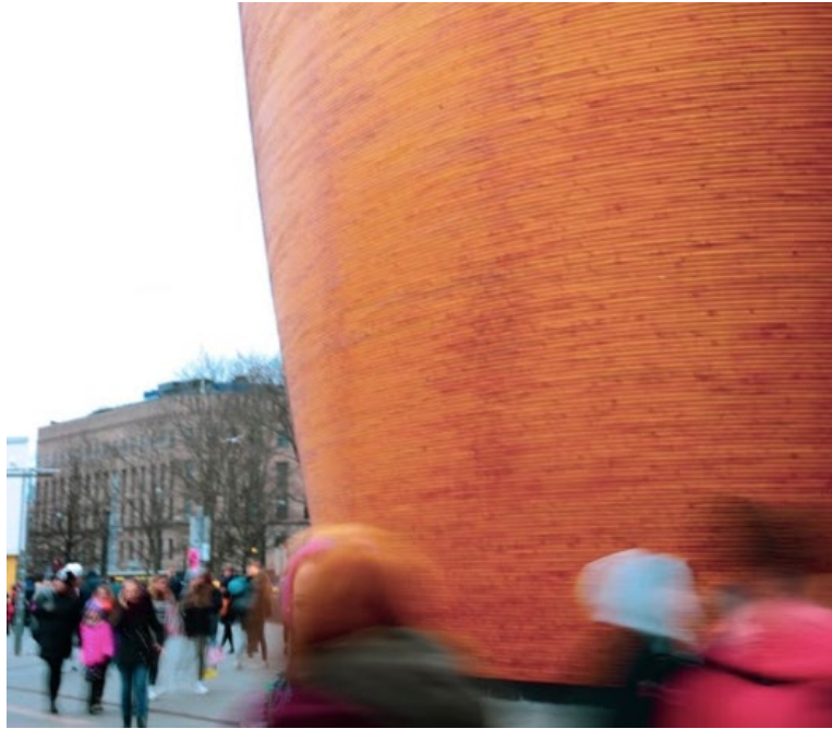
Kuva 66 – Kampin kappelin julkisivu on nanoteknologialla käsiteltyä kuusta (Kuva: Teemu Kiiveri)
