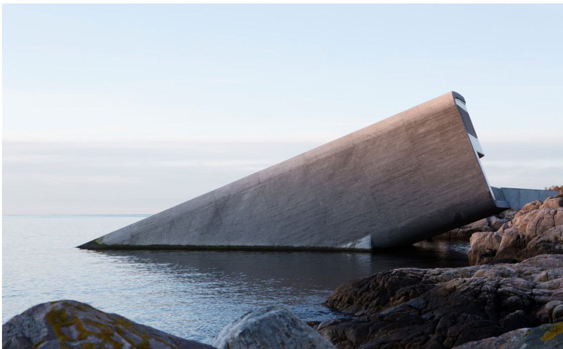
Kuva 115 – Under on osittain veden alle rakennettu ravintola ja tutkimuskeskus (Kuva: Inger Marie Grini / ArchDaily)
