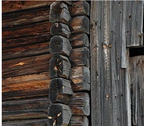
Kuva 3 – Lamasalvoshirsien liittymistä (Kuva: Kjetil Lenes)
