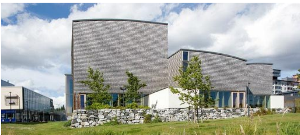
Kuva 37 – Viikin kirkon (Samuli Miettinen/JKMM, 2005) julkisivut palaavat kirkkoarkkitehtuurin perinteeseen. Julkisivut ovat haapapaanua. (Kuva: Helsingin seurakunnat)
