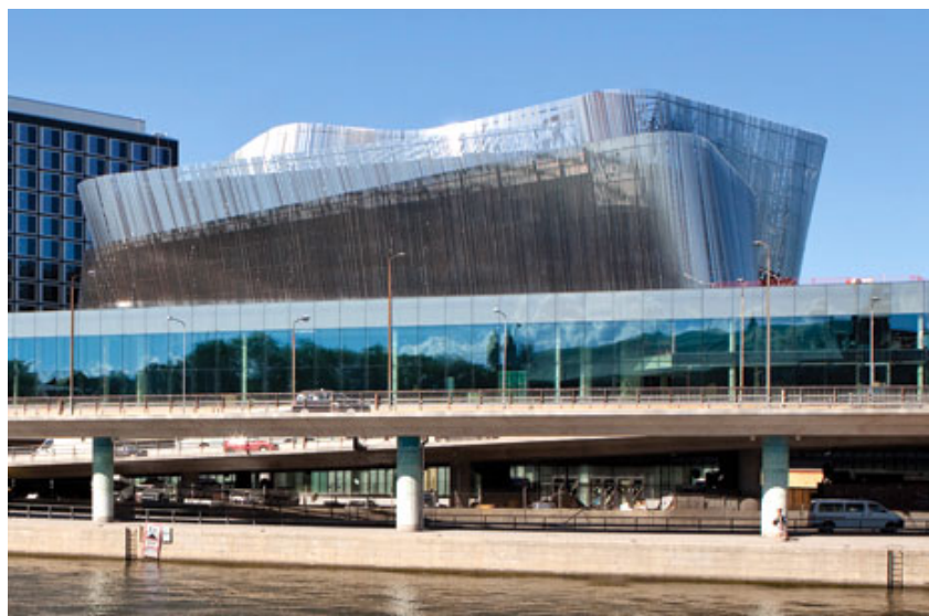
Kuva 102 – Tukholman Waterfront Congress Centren julkisivussa on käytetty ruostumatonta terästä. Suunnitellut White Arkitekter, 2011 (Kuva: Konferens)
