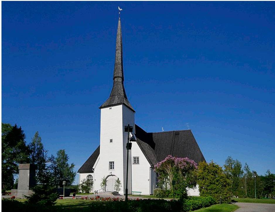
Kuva 8 - Vöyrin kirkossa on jyrkkä harjakatto ja korkea torni. Se on Suomen vanhin säilynyt tukipilarikirkko vuodelta 1627. (Kuva: Santeri Viinämäki)
