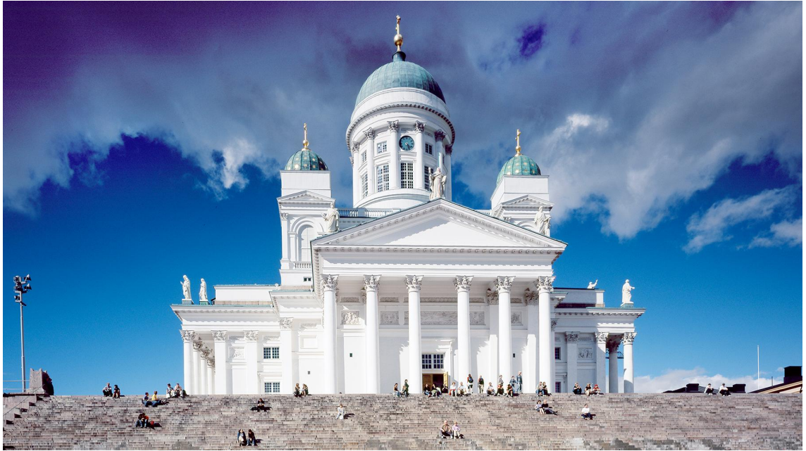
Kuva 16 – Helsingin Tuomiokirkko on pääkaupungin symboli. Kuvassa näkyvät päätykolmioiden yllä sinkkipatsaat sekä keskuskupolin viereen lisätyt kulmatornit (Kuva: helsingintuomiokirkko.fi)
