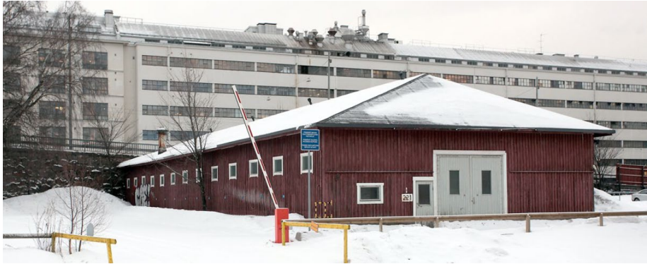
Kuva 56 Puolivalmistevarasto, toiselta nimeltään varaosavarasto, on sijainnut suunniteltualueen tontilla vielä 2012. Muuten aluskehysosaston eteläpuoli oli pitkään vain autojen pysäköintialueena. Taustalla näkyy SOK:n rakennus.
