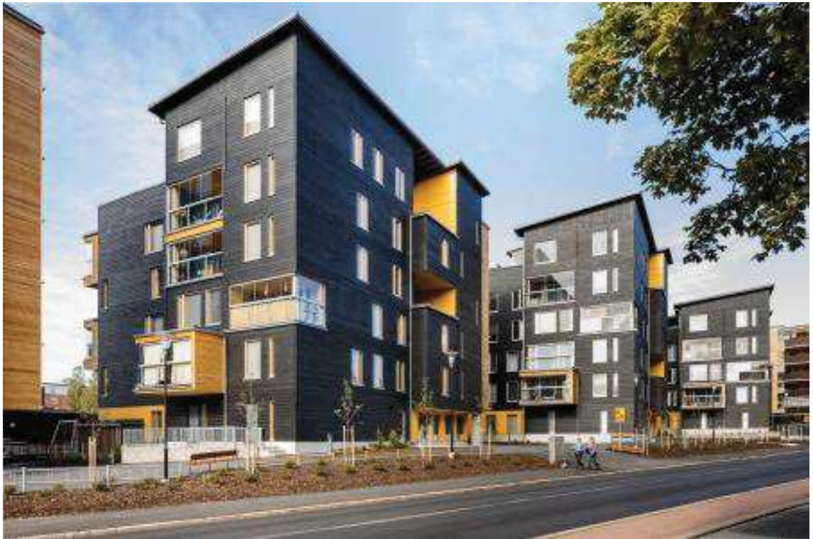
Kuva 2. Puukerrostalot Haso & Heka, Helsinki. Matti Iiramo. 16
