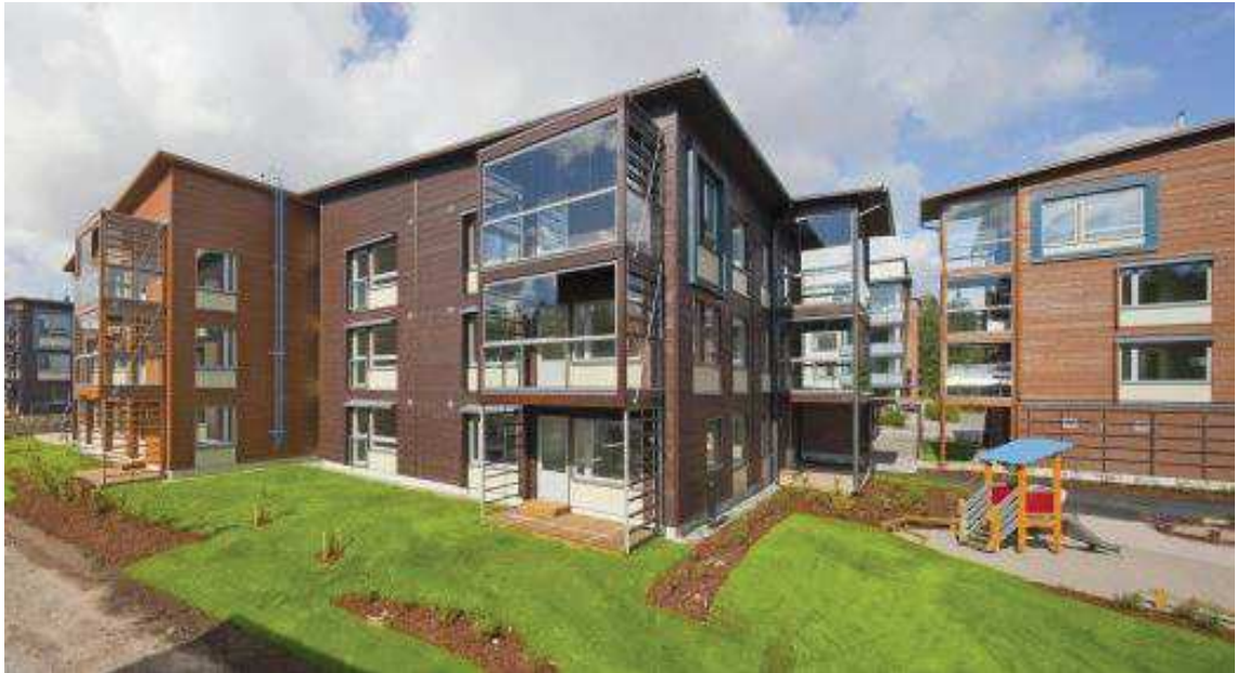
Kuva 15. Viikin puukerrostalokorttelin rakennuksissa on pilari-palkkirakenne. 3
