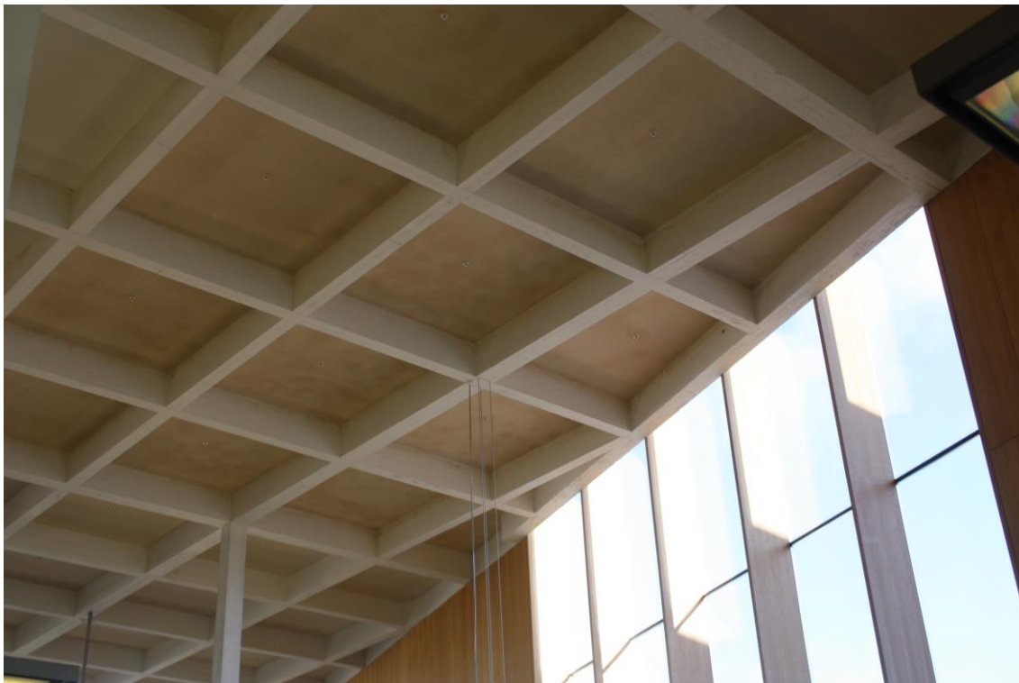
Kuva 14. Turun pääkirjaston katon betonirakenteita. Kuva: Annika Kauppi.
