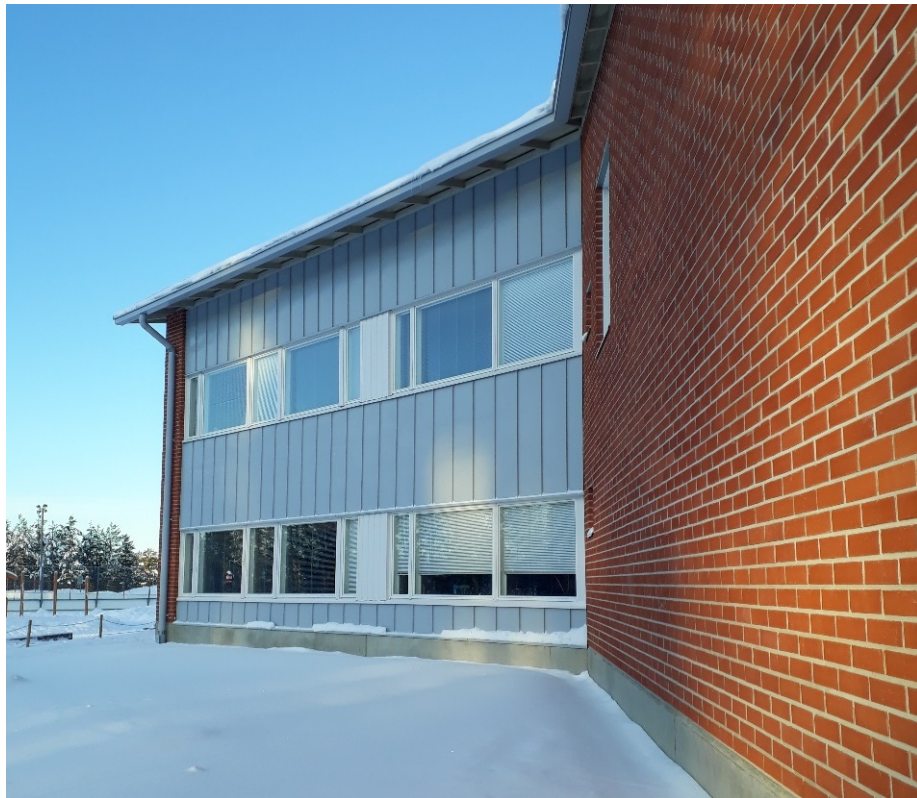
Kuva 5 Alakoulun laajennuksen pystysuuntainen julkisivupelti on väriltään sinertävää ja leveämpää kuin muiden rakennusosien pelti. (Anna Koskela 2019)
