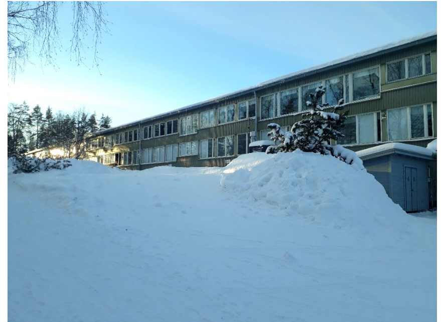
Kuva 30 Parikkalan koulukeskuksen purettavan osan itäjulkisivu. (Anna Koskela 2019)
