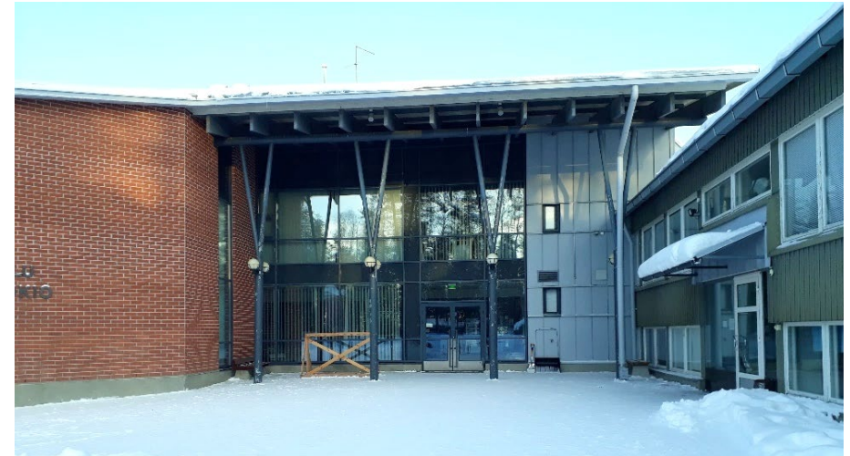
Kuva 7 Alakoulun laajennuksen sisäänkäynti toimii rakennuksen pääsisäänkäyntinä. Oikealla purettava rakennusosa. (Anna Koskela 2019)
