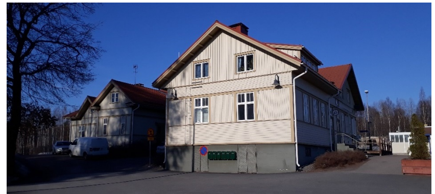
Kuva 17 Asemarakennuksen laajennusosat ulottuvat selkeästi alkuperäisestä suorakaiteisesta massasta. (Anna Koskela 2019)
