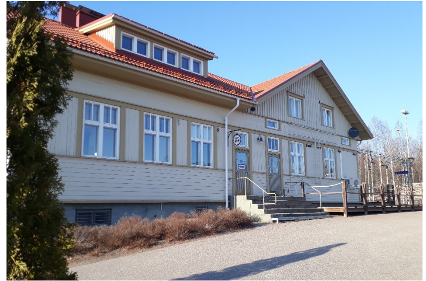
Kuva 16 Parikkalan asemarakennus valmistui vuonna 1917 Thure Hellströmin suunnittelemana. (Anna Koskela 2019)
