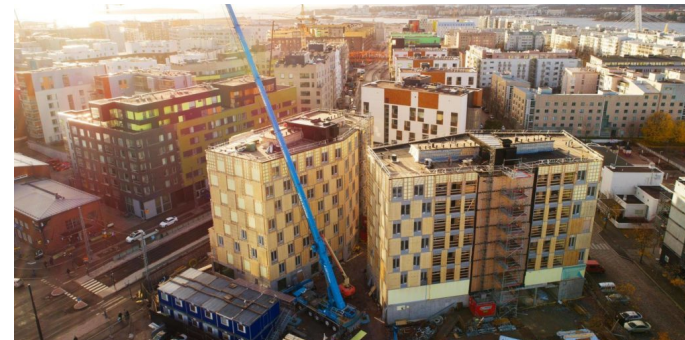
Kuva 6. Wood Cityn rakenteilla olevat puukerrostalot Helsingin Jätkäsaarella. (www.rakennuslehti.fi)
