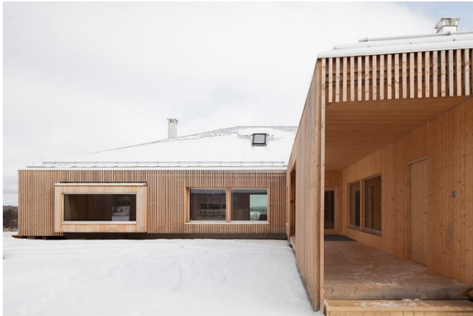
Kuva 9. OOPEAA:n House Riibi -pientalon julkisivut on päällystetty puusäleiköillä. (www.archdaily.com)
