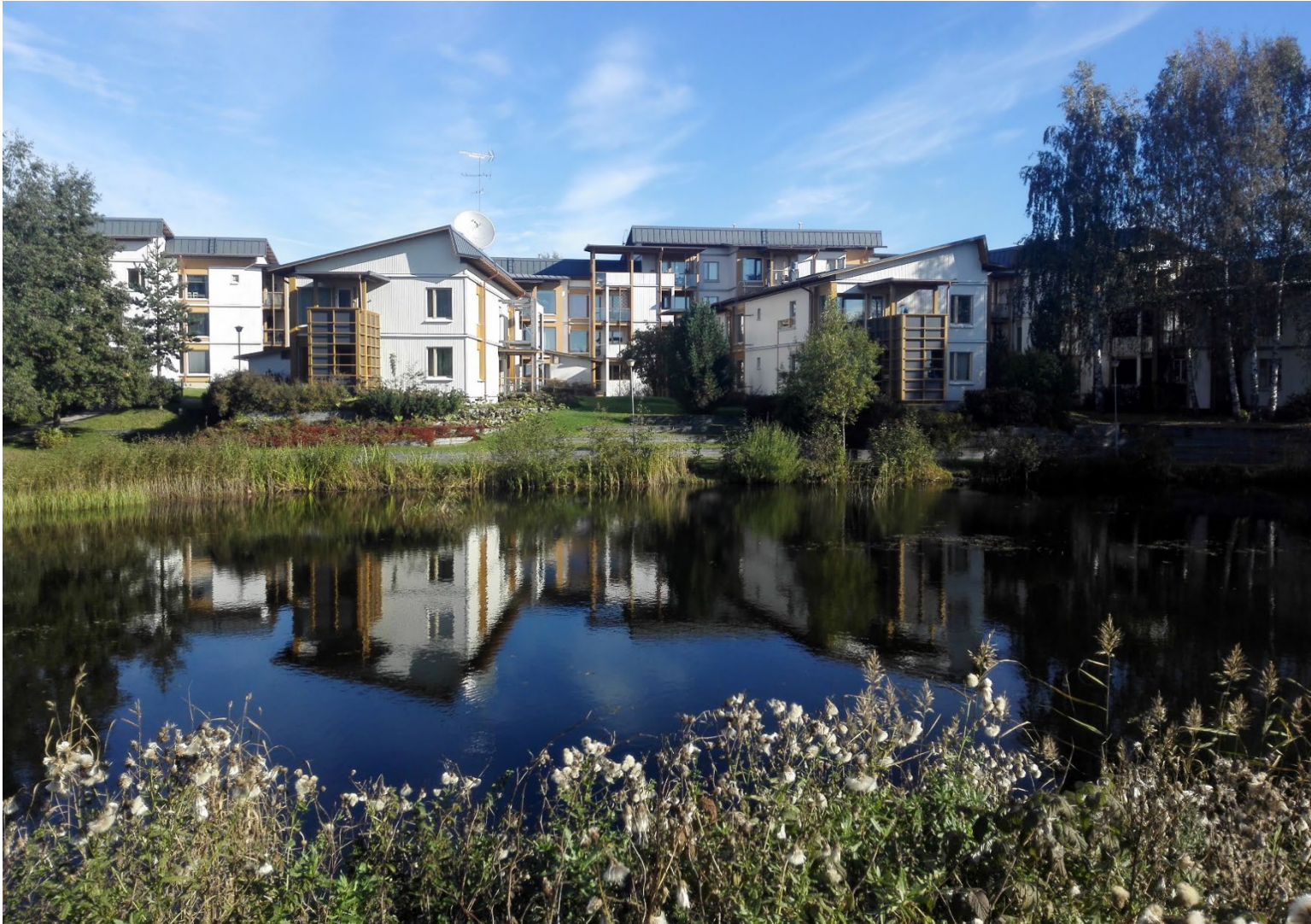
Kuva 1. Kiinteistö Oy Viihinmansion oli ensimmäinen punkerrostalokohde Suomessa.
