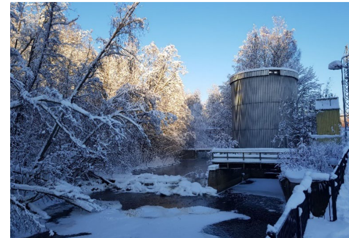
Kuva 38. Tourujoki ja suojeltava vesivoimalaitos.
