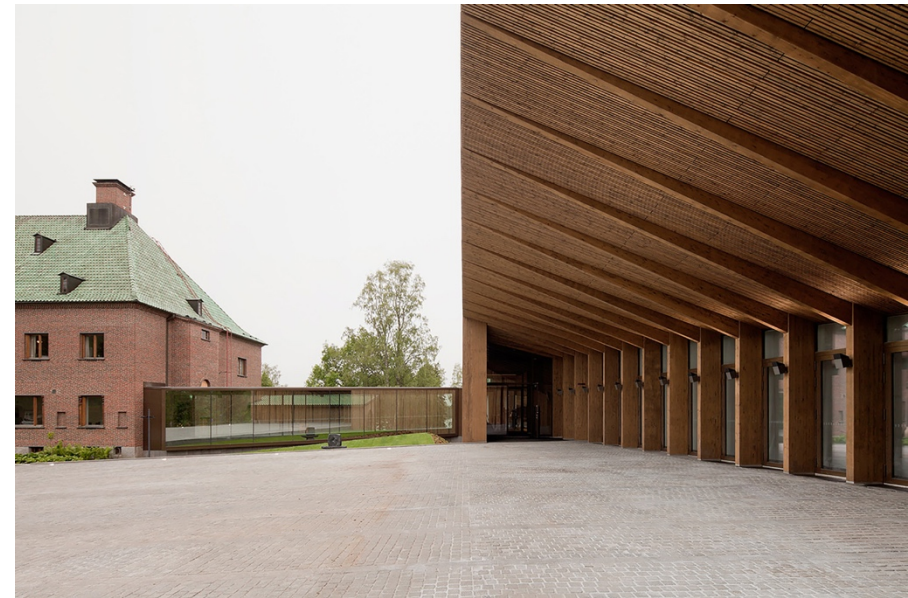
Kuva 4. Lasinen yhdyskäytävä kytkee uuden ja vanhan osan toisiinsa. (4)
