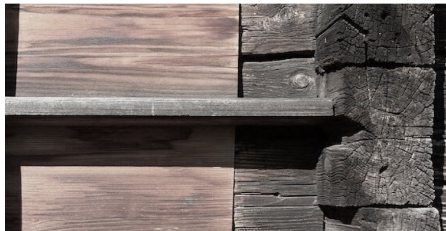
Kuva 43. Rakennuksen uusi ja vanha osa on yhdistetty konstailemattomasti (12)
