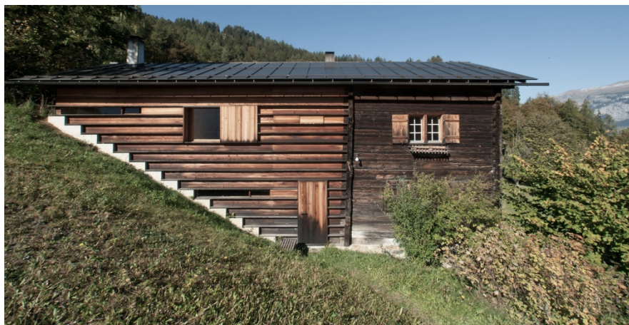
Kuva 42. Rakennuksen uusi ja vanha osa muodostavat yhtenäisen ja harmonisen, mutta kerroksellisen kokonaisuuden (11)
