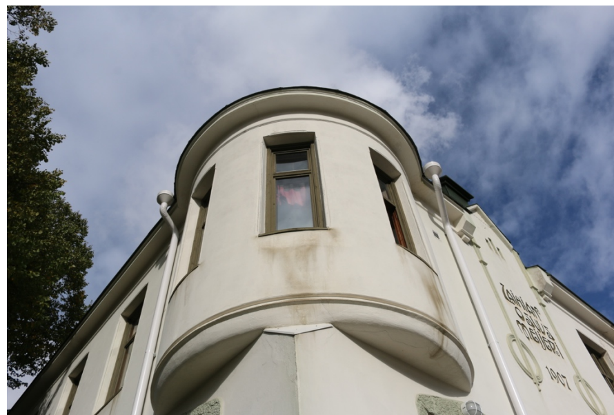
Kuva 39. Kaakon ja lounaan julkisivujen kulmaan sijoittuva tornimainen erkkeri on yksi rakennuksen näyttävimmistä elementeistä. Erkkeri tuo toisen kerroksen asuntoon arvorakennuksen henkeä ja kasvattaa asunnon tilallista mielenkiintoisuutta.
