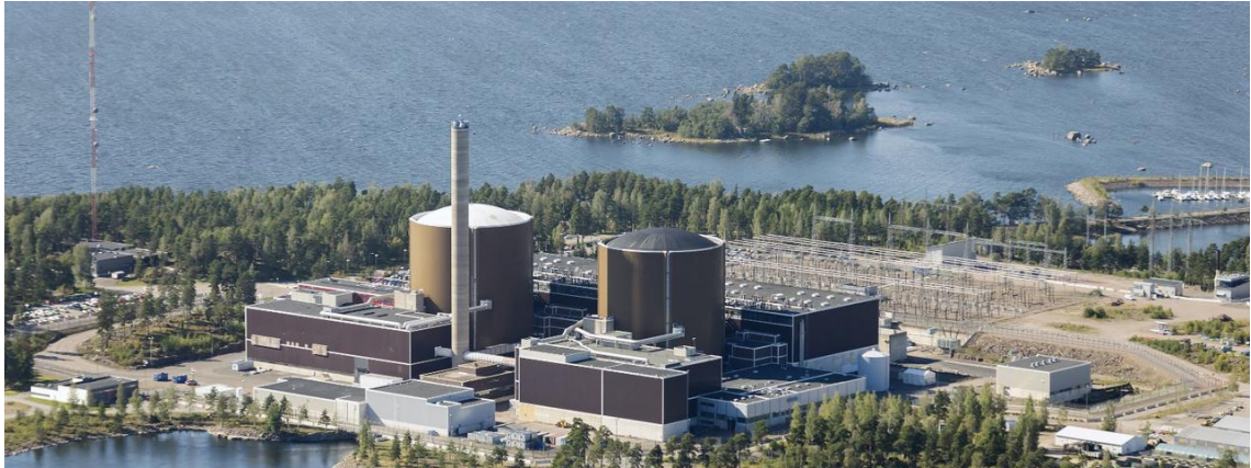
Kuva 3. Loviisan ydinvoimalaitos kuvattuna koillisesta [Loviisan ydinvoimalaitos 2018].
