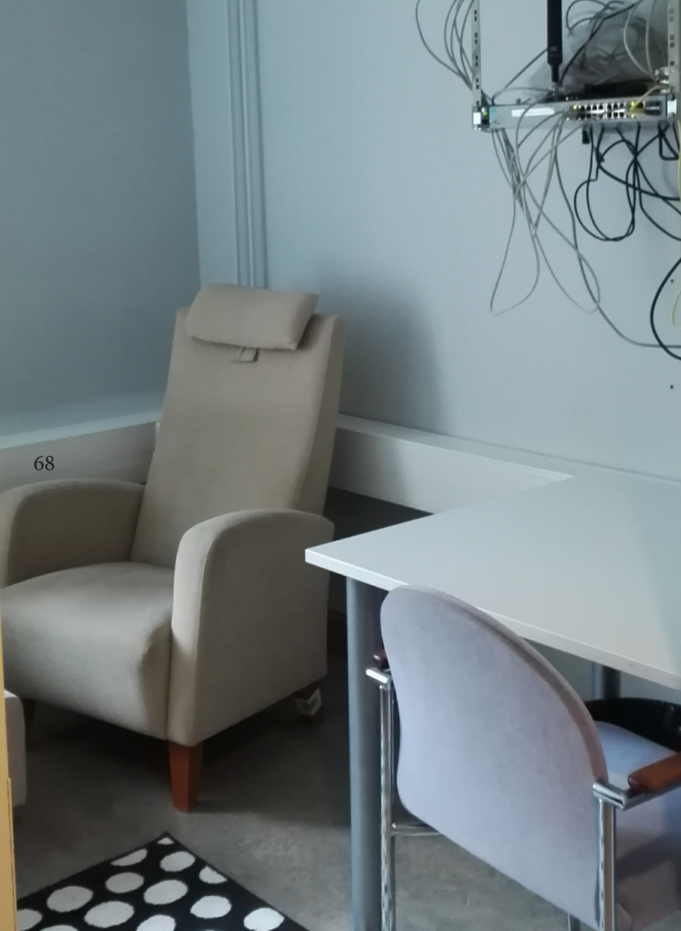
Kuva 21. Sähköt piilotetaan näkyvistä. (Pääkkönen 2017)
