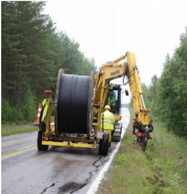
KUVA 12. Kaapelin aurausta (Nestor cables 2015, 131)
