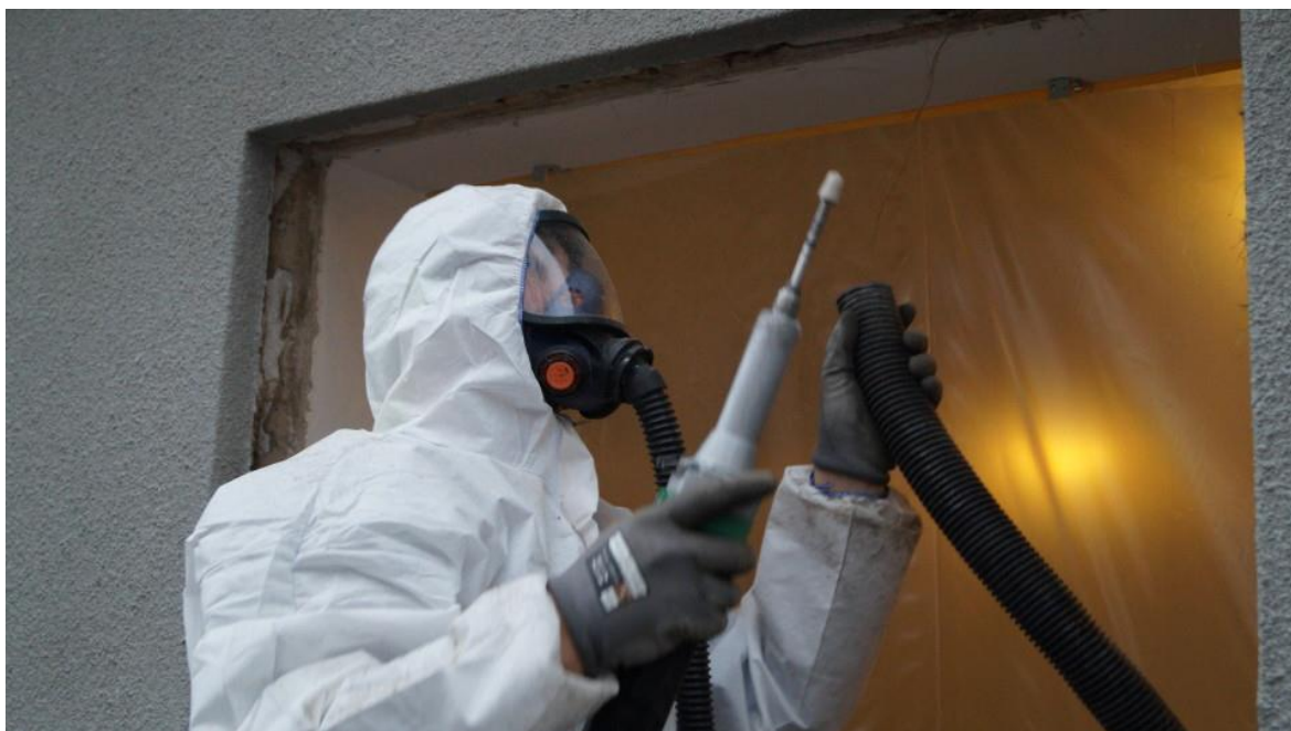
Bild 11. Utstyrsel samt en del verktyg som används vid asbestsanering, Corvara.se
