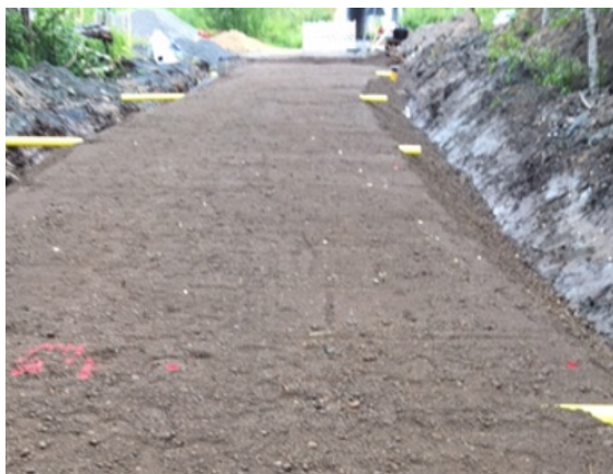
Kuva 2. Putkien asennus testialueelle, Fill-R-rakennekerrokseen (Juola 2018)
