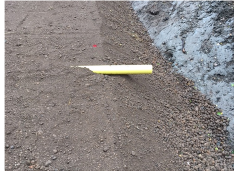
Kuva 11. Tiivistetty Fill-R-rakennekerros (Juola 2018)
