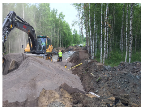
Kuva 7. Pohjatuhkan levitys rakenteeseen (Juola 2018)
