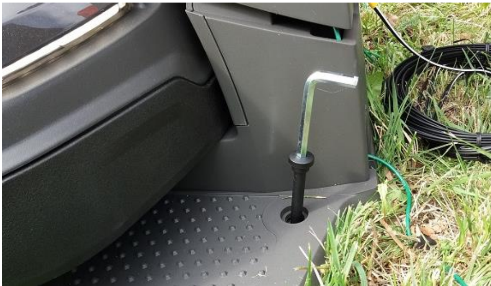
Kuva 6. Latausaseman maahan kiinnitys ruuveilla Espoossa.
