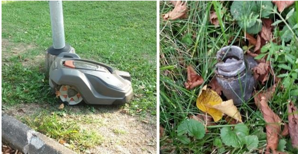
Kuva 41. Vasemmalla kuvassa robottiruohonleikkuri jumissa Espoossa ja oikealla vanhan kastelusteemin pää, johon robottiruohonleikkuri jäi kiinni.
