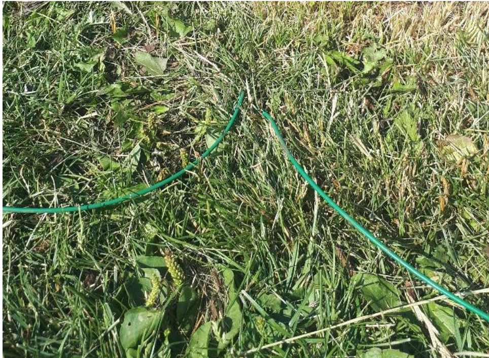
Kuva 42. Katkennut kaapeli 01.08.18 (Salo, 2018).
