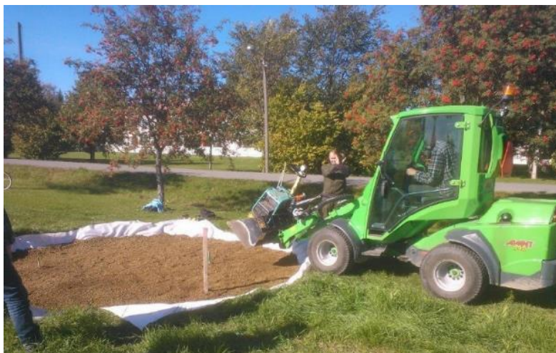
Kuva 4. Hämeen ammatti-instituutin opiskelijat rakentamassa ykkösväylän heittopaikkaa. Kuva: T. Vähä-Piikkiö
