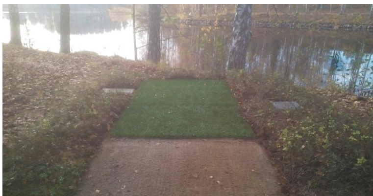
Kuva 12. Kunttareunus asentamisen jälkeen. Kuva: T. Vähä-Piikkiö
