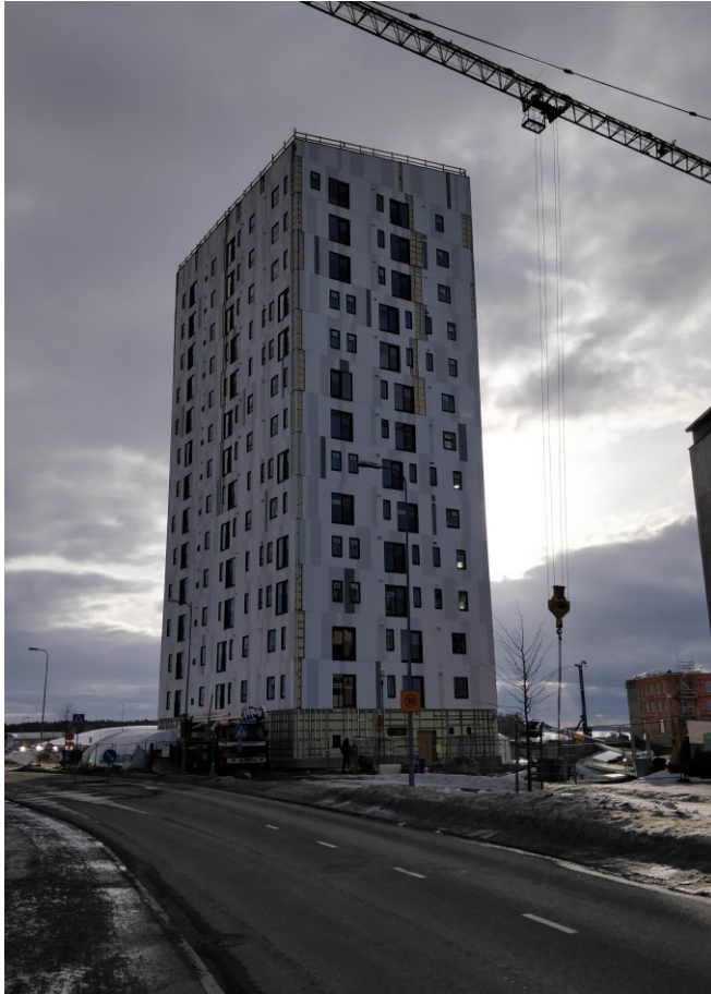
Kuva 1. Joensuun puukerrostalo Lighthouse.
