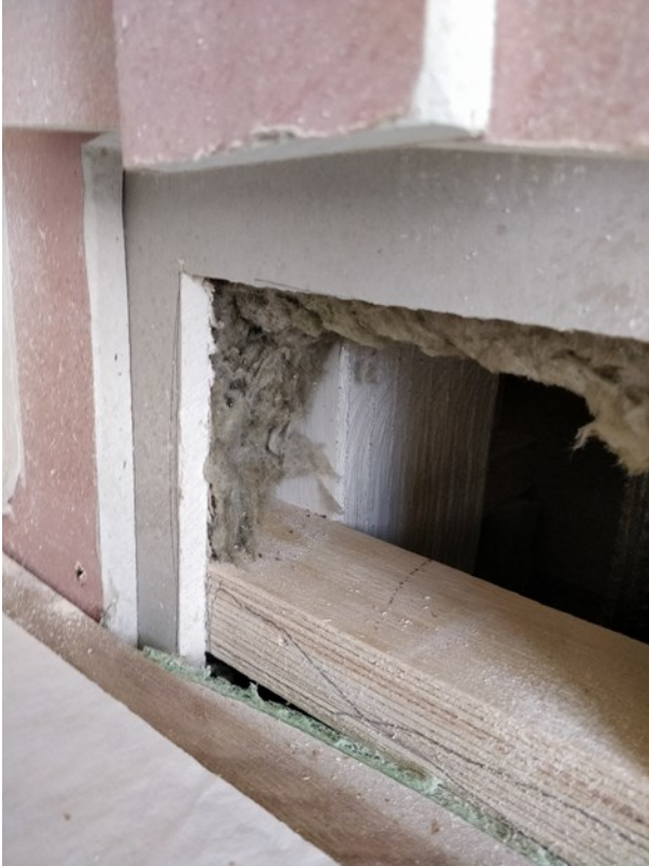
Kuva 5. Kuva otettu huoneistojen välisestä seinästä 5. kerroksesta seinän 2 kohdalla. Kuvan aukossa on jännetanko, siksi seinän alalaitaan on jätetty reikä rakennusvaiheessa.
