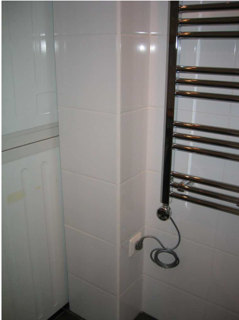
Kuva 3. Viemärikotelo ja räätipatteri.
