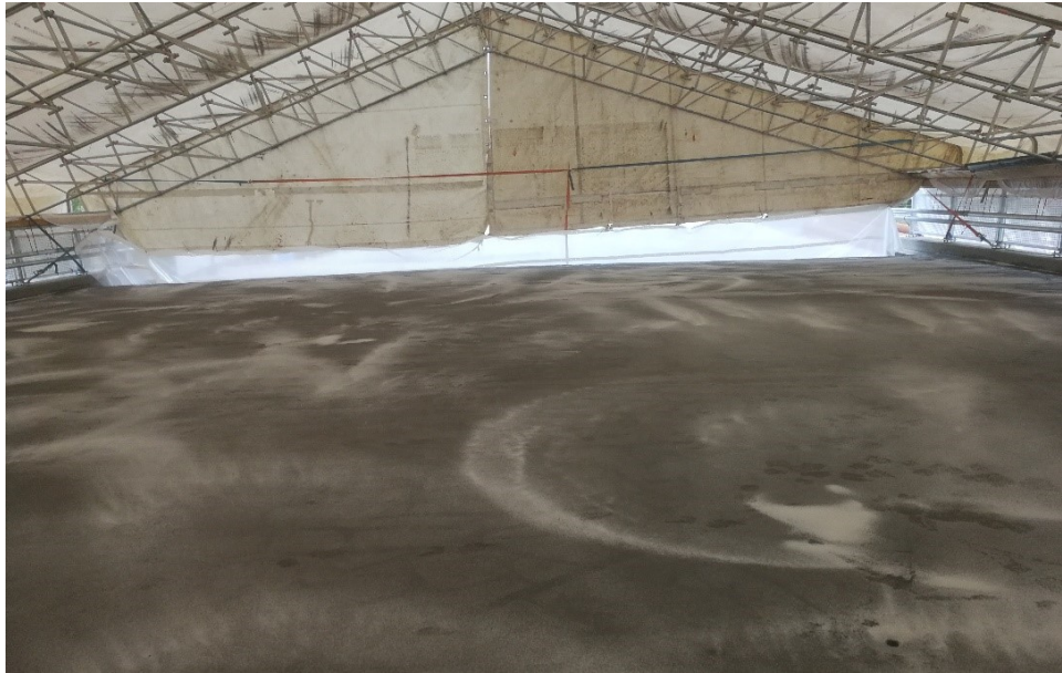
Kuva 7. Mapeprimer M levitettyä ja kvartsihiekkakerros heitettyä. Kvartsihiekkakerros puhalletaan vielä lehtipuhaltajalla tasaiseksi.
