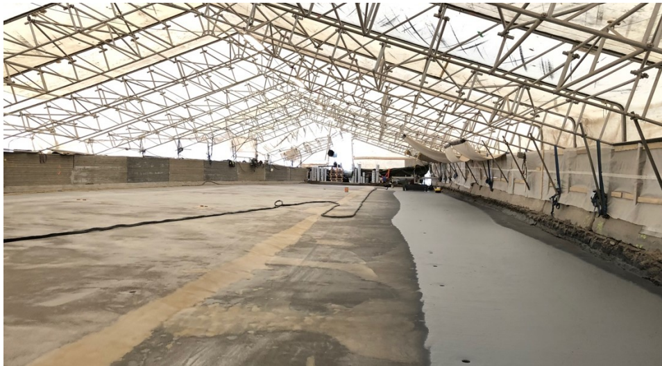
Kuva 4. Oikeassa laidassa valmista Purtop 400 M pintaa, vasemmalla Mapeprimer M pohjuste, jossa näkyvillä myös hiekkapoksilla tehtyjä korjauksia.
