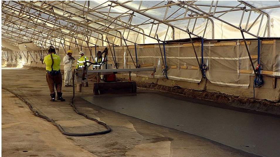
Kuva 3. Nestemäisenä levitettävän vesieristyksen ruiskutusta robotin avulla.
