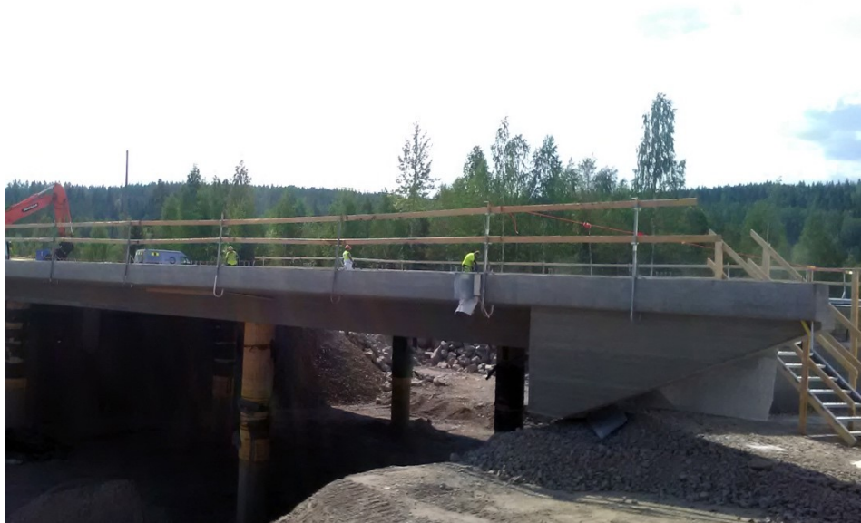
Kuva 10. Eristystyö ilman sääsuojaa. Putoamissuojat asennettuna reunapalkkiin.
