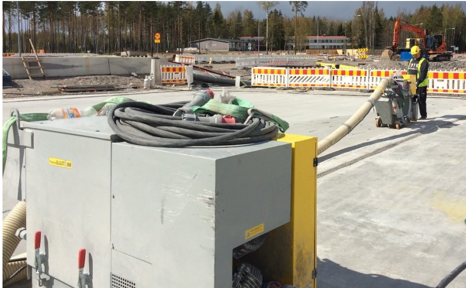
Kuva 2. Alustan esikäsitteily sinkopuhalluslaitteistolla
