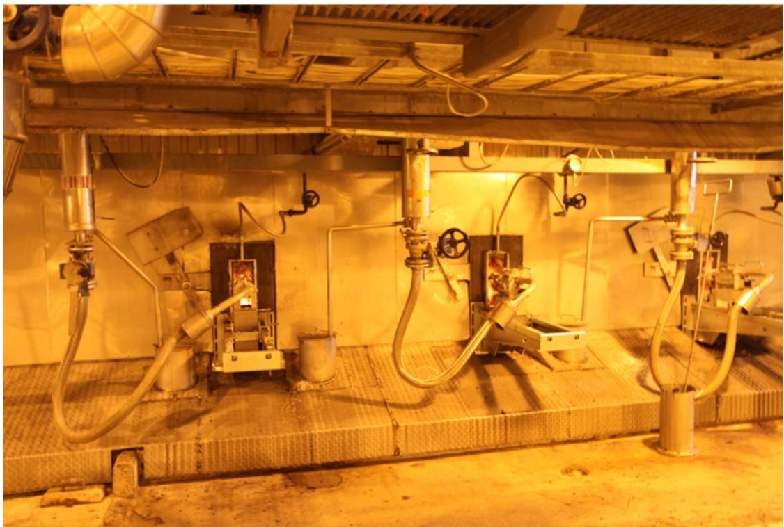
KUVA 3. Lipeäruiskuja kattilan seinässä (Knowpulp)
