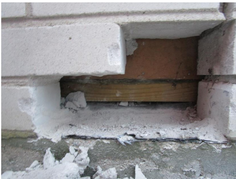
Kuva 6. Kuvassa on julkisivun tiilimuurauksesta irrotettu tiili rakenteen tarkastusta varten.
