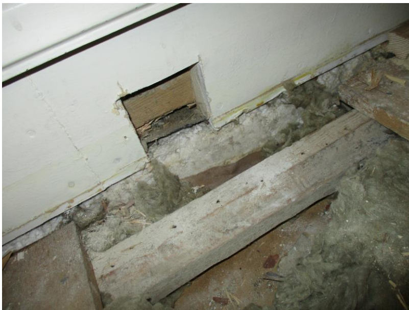
Kuva 5. Kuvassa on avattu seinä-lattialiittymä, mistä pystyy tarkistamaan seinän- ja lattianrakenteet ja niiden liitokset.
