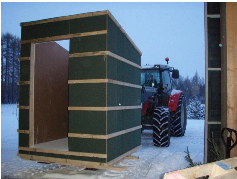
Kuva 19. Rakennuksen siirto katon asennuksen ajaksi
