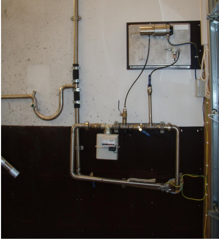
Kuva 14. Vuonna 2008 rakennetun biokaasureaktorin putkistoa.
