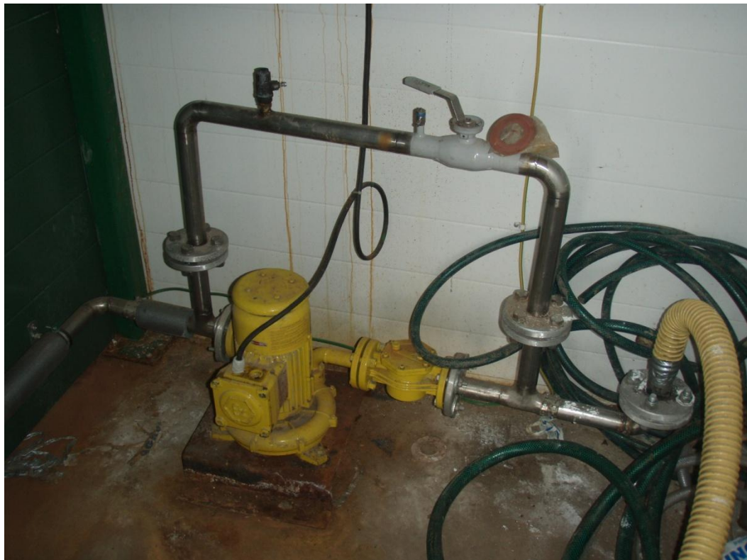
Kuva 6. Biokaasuputkistoa länsisuomalaisella maatilalla
