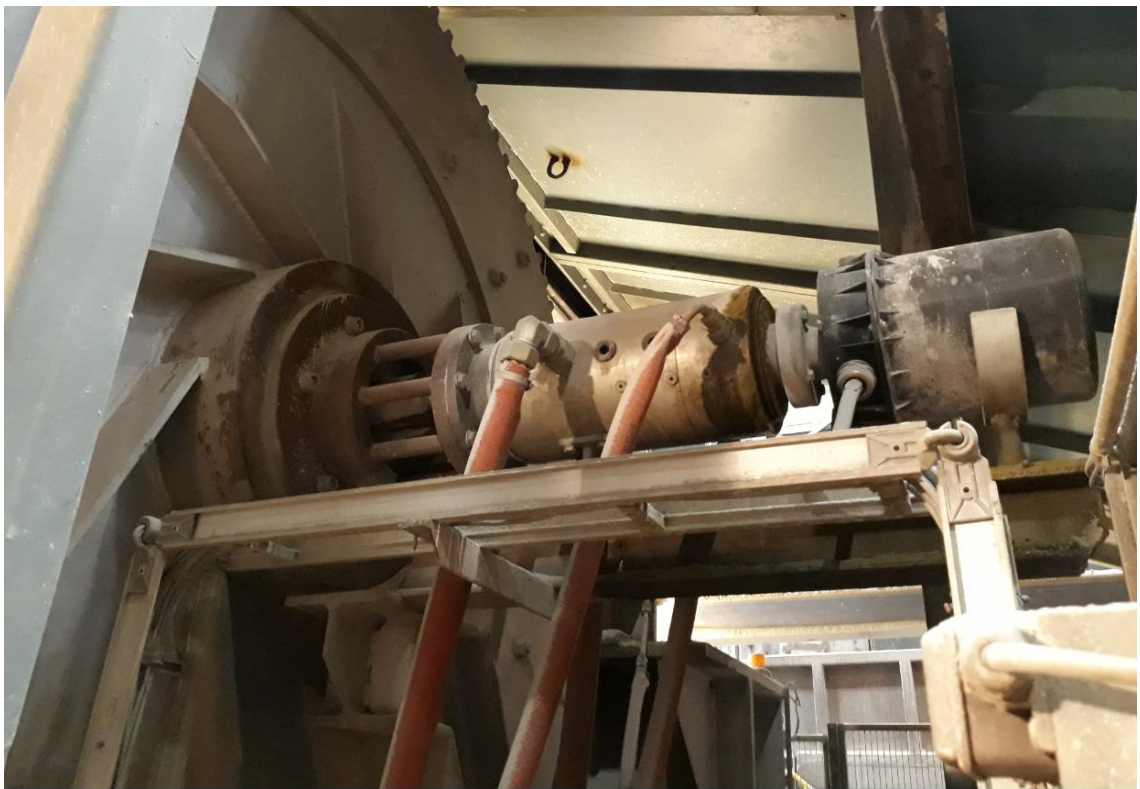
Kuva 20. Purettavat osat isolta hammasrattaalta
