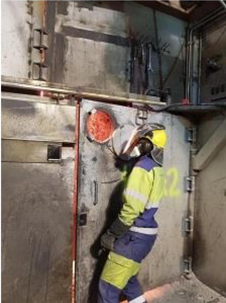
Kuva 6. Senkan kunnostuspaikan suojaseinät
