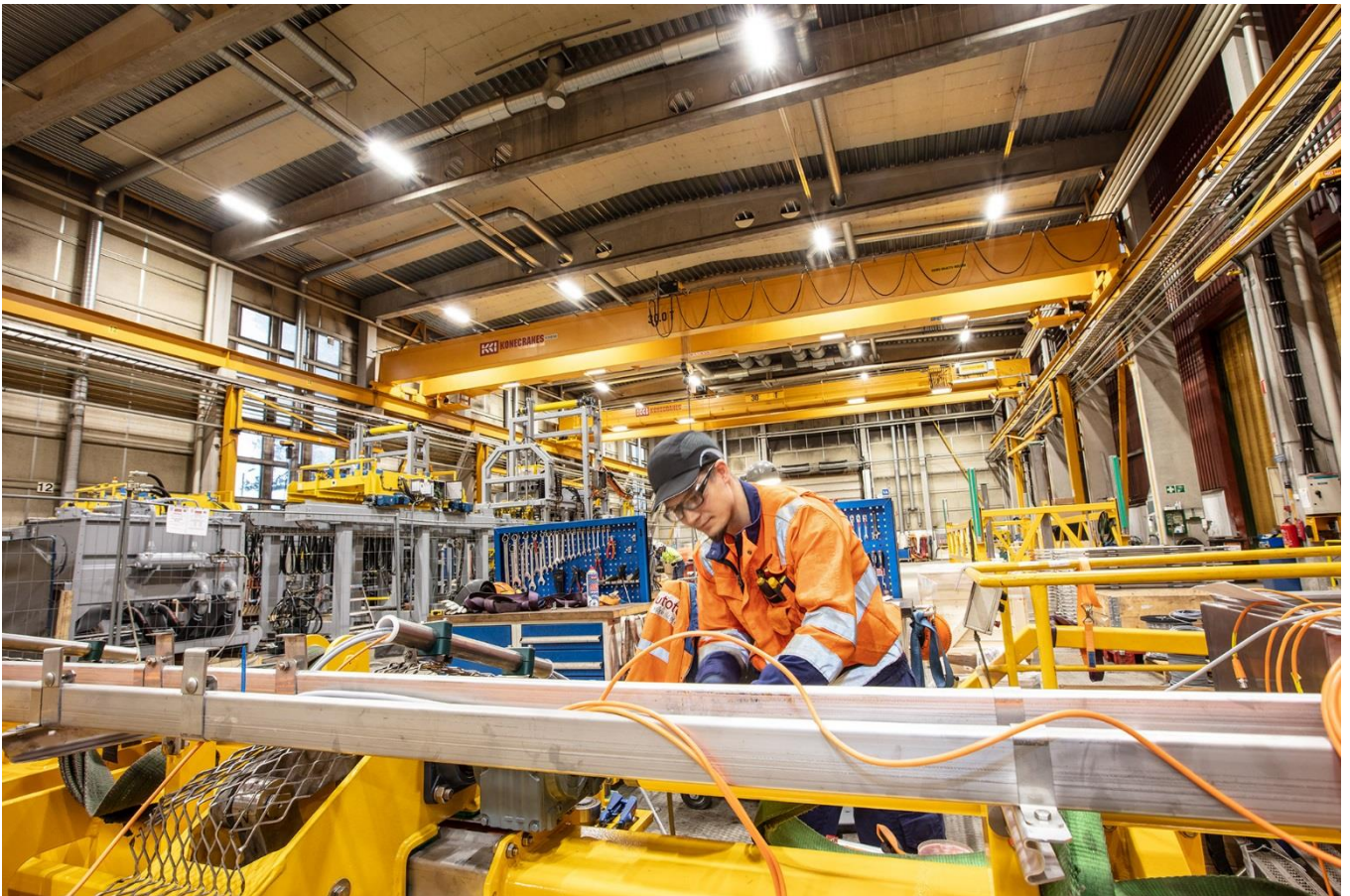
KUVA 15. Uusi valaistus kohteessa. (Greenled 2019a.)
