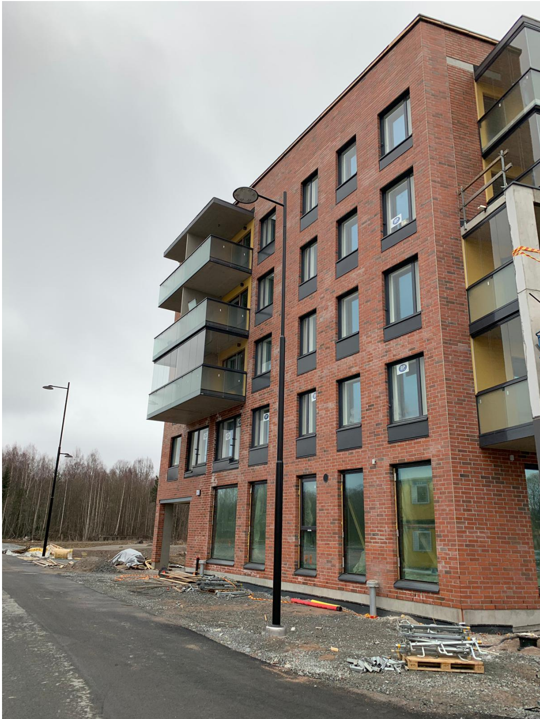
Kuva 2. As Oy Hämeenlinnan Login julkisivumuuraus.
