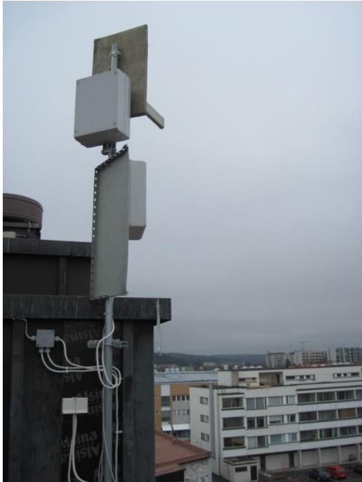
Kuva 9: Kuva edellä mainittujen kolmen (3) kameran vastaanottoantennista, joka sijoitettu Helsingintien ja Horninkadun kulmassa olevan If-vakuutusyhtiön katolle.
