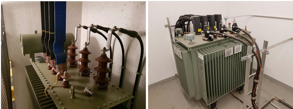
Kuva 26. Esimerkkikuvat vuosina 1983 (vas.) ja 2013 (oik.) tehdyistä muuntaja-asennuksista.
