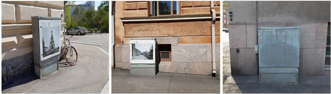
Kuva 4. Maastosuunnittelussa kartoitetut vanhat jakokaapit. Kaksi vasemmanpuoleisinta voidaan korvata eri kohtaan asennettavilla kaapeilla, mutta oikeinpuoleisin todettiin maastosuunnittelun yhteydessä korvattavan samoille kohdin.
