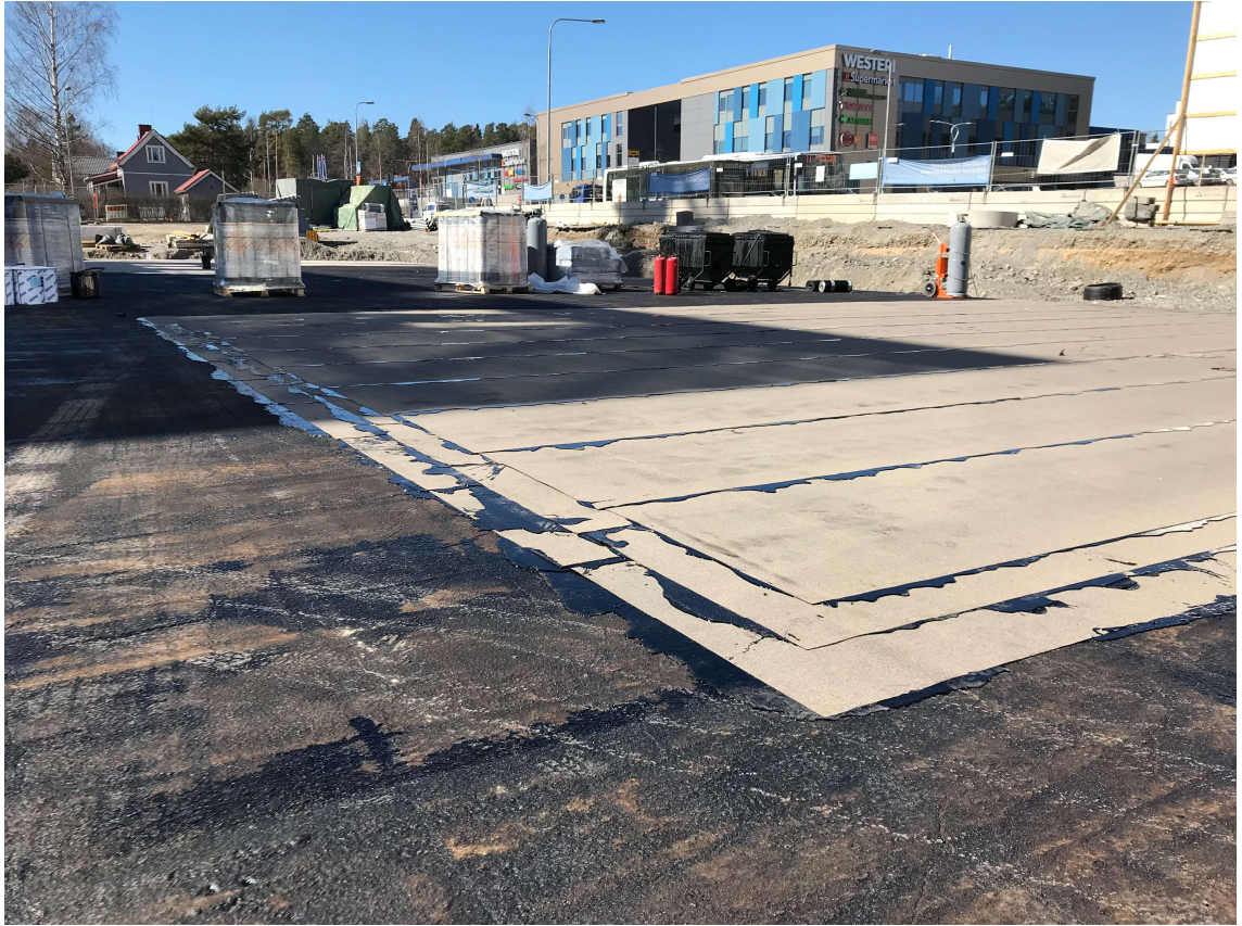
KUVA 11. Käännetyn rakenteen vedeneristyskerros.
