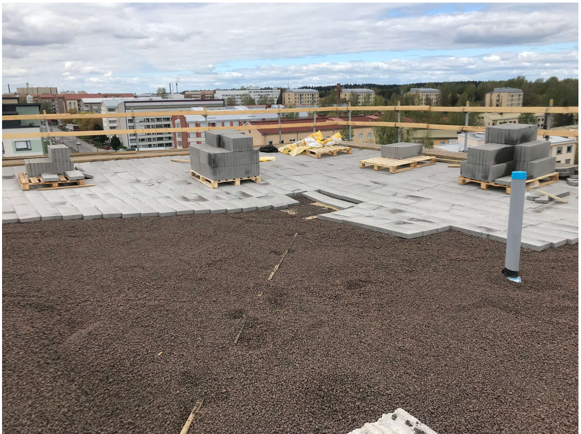
KUVA 8. Kevytsorakerroksen päälle ladottua katelaattaa.
