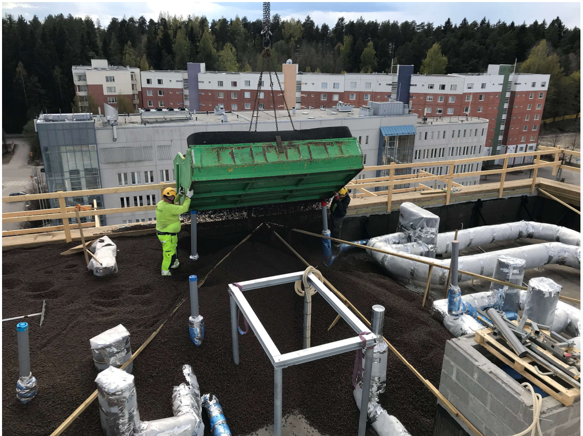
KUVA 7. Kevytsoran asennusta nostolaatikon avulla.
