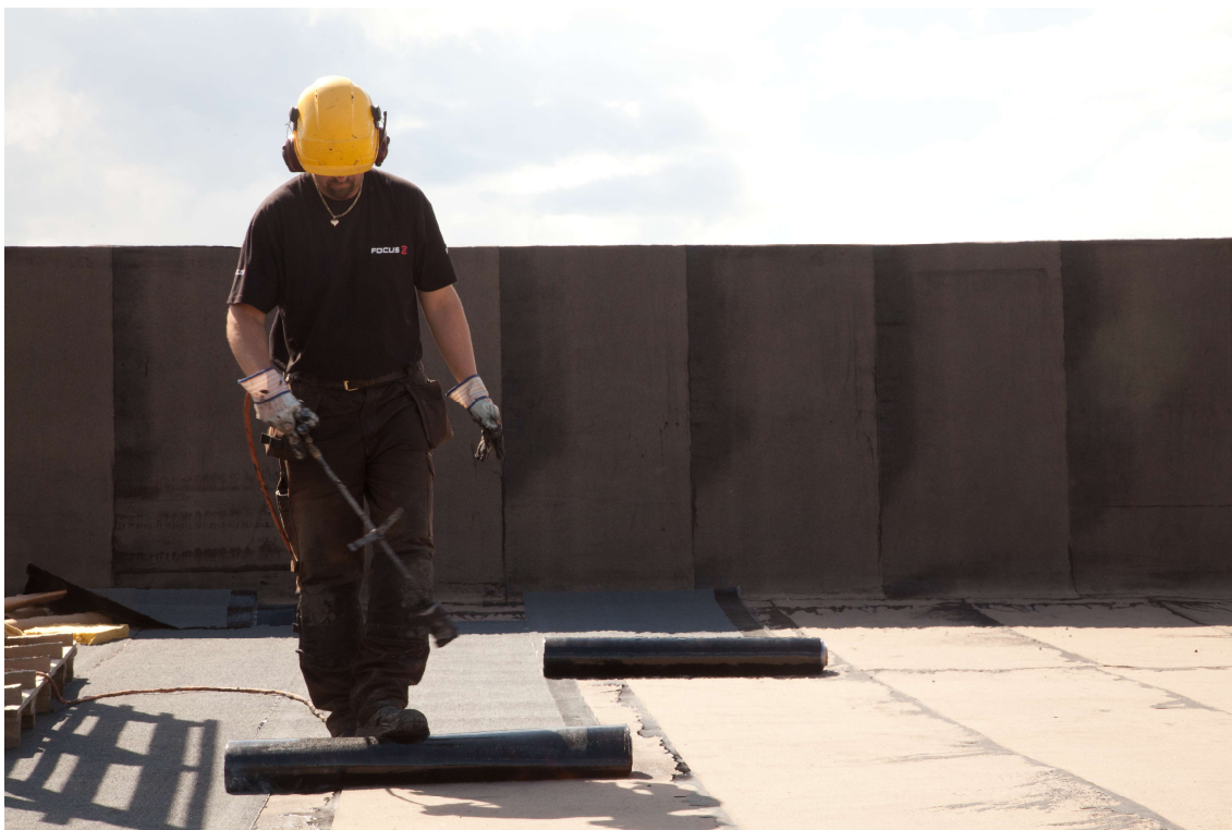
KUVA 2. Pintakermin asennus (Katehuolto 2012)
