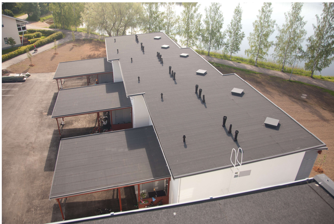
KUVA 12. Yleisimpiä läpivientejä katolla. (Katehuolto 2012)
