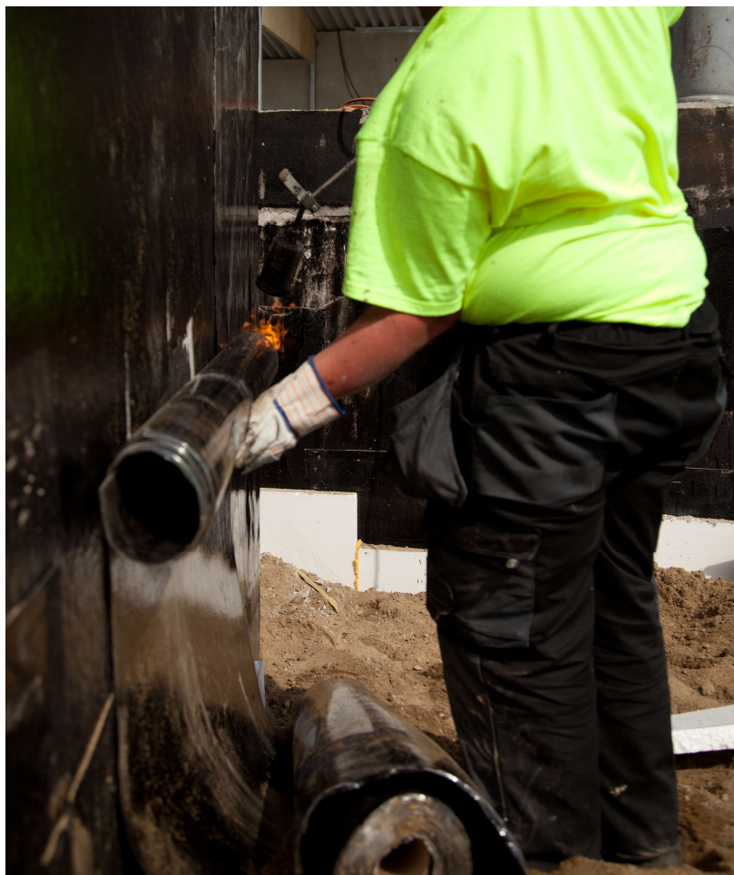
KUVA 5. Seinäeristyksen asennus. (Katehuolto 2012)
