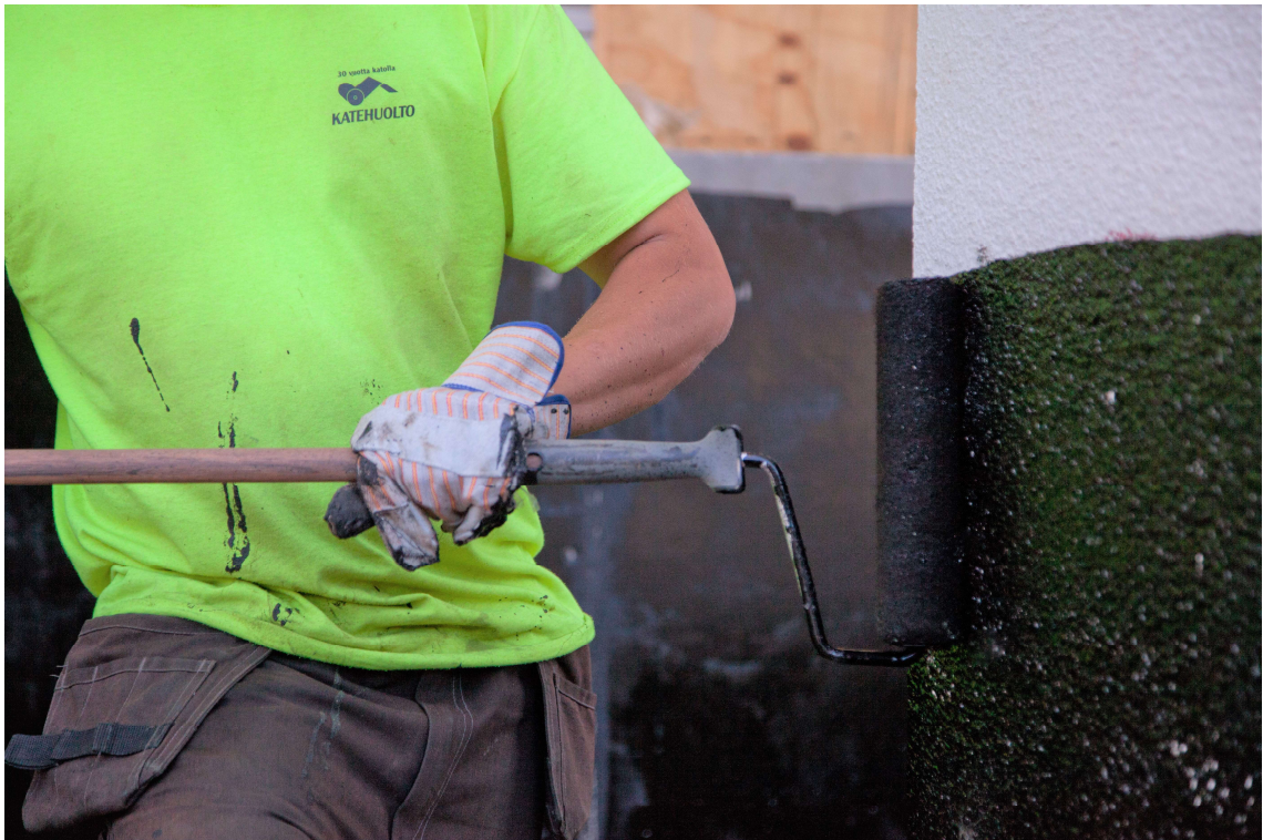
KUVA 3. Liuoksen levittämistä bitumikerman tartuntapohjusteeksi (Katehuolto 2012)
