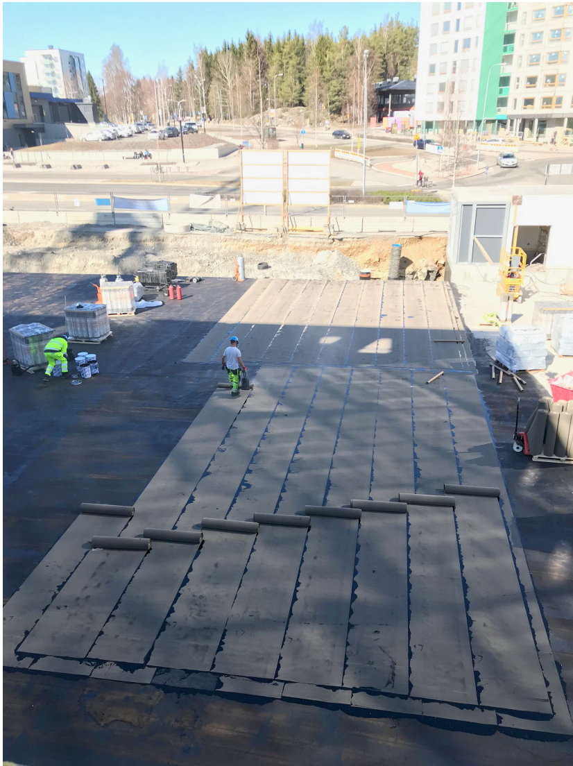
KUVA 10. Käännetyn rakenteen vedeneristystä.
