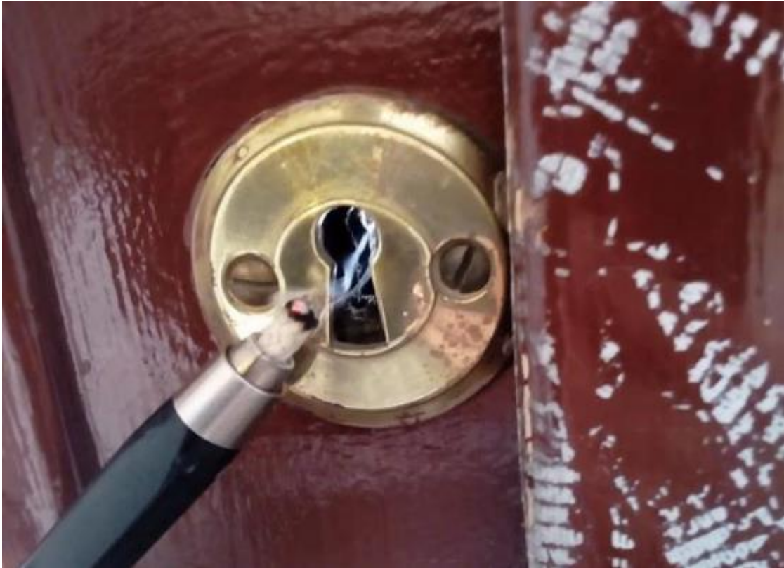
KUVA 16. Savukynää hyödyntäen tutkittiin rakennuksen sisäisiä ilmavirtoja
