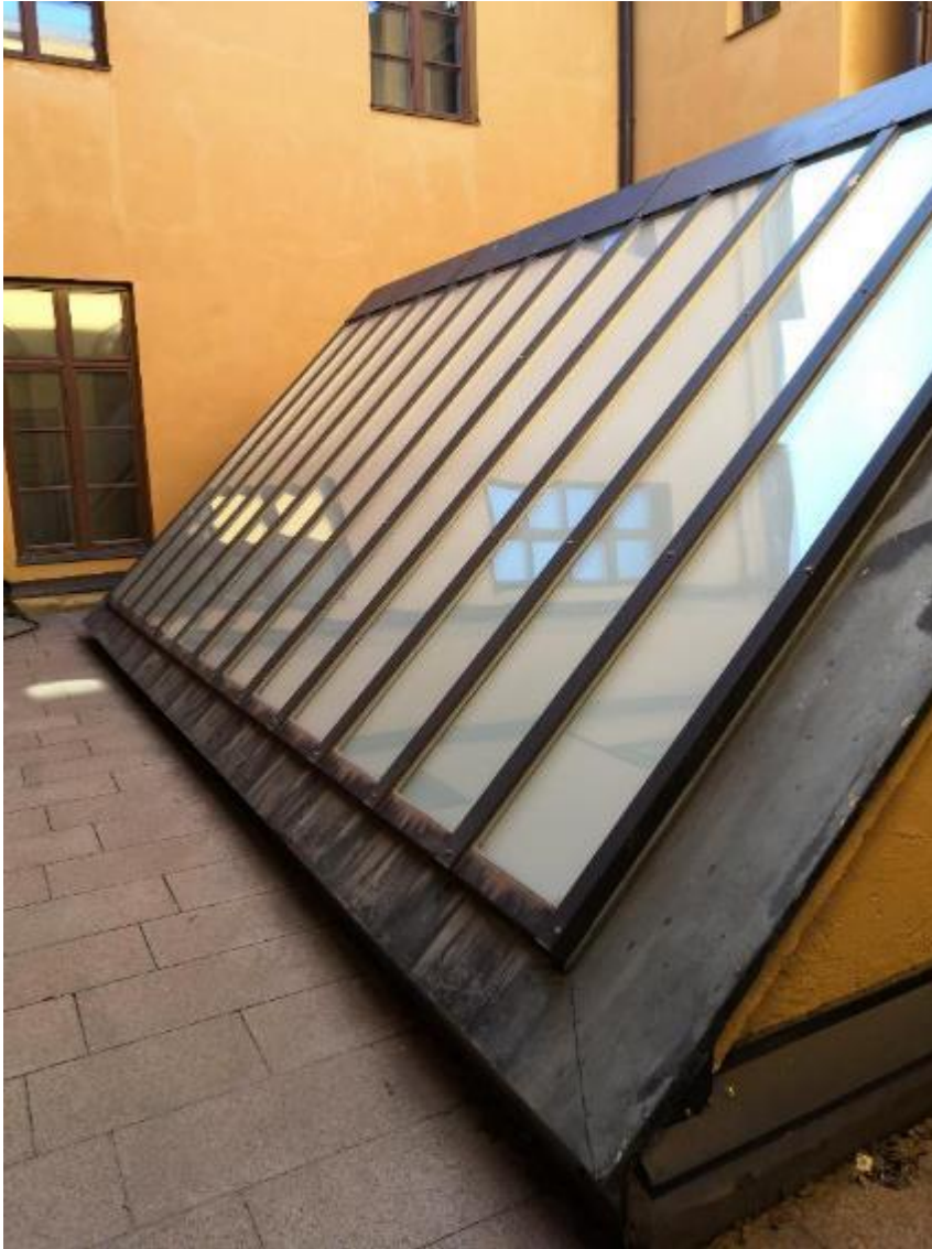
KUVA 4. Sisäpihaa hallitsee kattoikkuna
