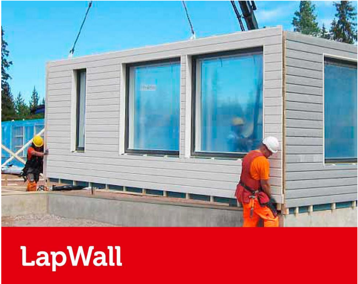
Kuvio 17. Elementtien asennus (lapwall.fi)
