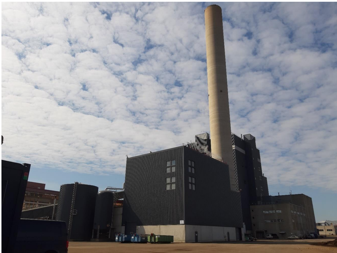
Kuva 3 Kainuun Voiman lämmön- ja sähkön yhteistuotantolaitos (Teemu Rissanen, 20.04.2019)
