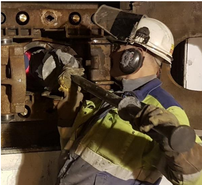
Kuva 7. Suutiilen asennus paikalleen.
