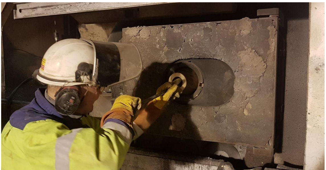
Kuva 10. Ylälevyn kiinnitysmassan poisto valureiän sisäpuolelta.
