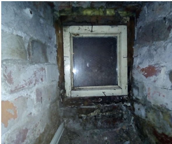
Kuva 14. Maan alle jäänyt kellarin ikkuna.
