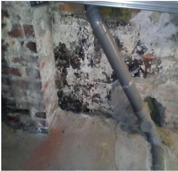
Kuva 13. Kivihiilipikeä kellarin ulkoseinässä.
